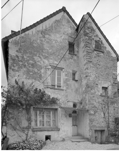
Vue de la façade avec l'escalier demi hors oeuvre. Phot. Thierry Lefébure IVR22_19950200395V
