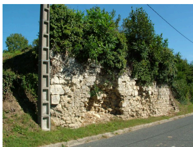
Ruines de l'ancien village dans la rue Principale. Phot. Inès Guérin IVR22_20030202480NUCA
