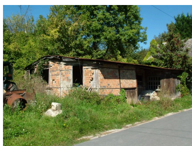
Restes d'une maison provisoire, 9 rue des Bons Enfants. Phot. Inès Guérin IVR22_20030202483NUCA
