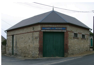
Vue de la pompe à incendie. Phot. Irwin Leullier IVR22_20050200979NUCA
