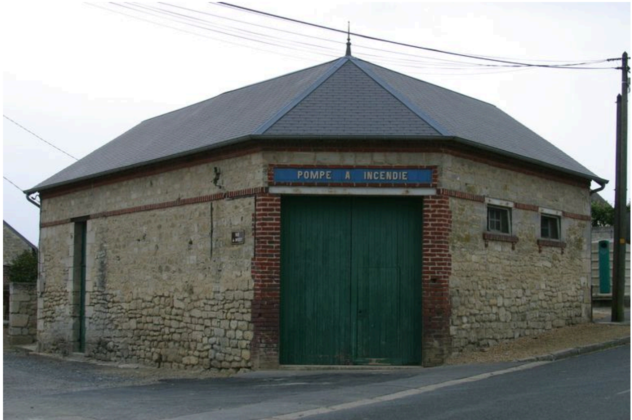
Vue de la pompe à incendie.
