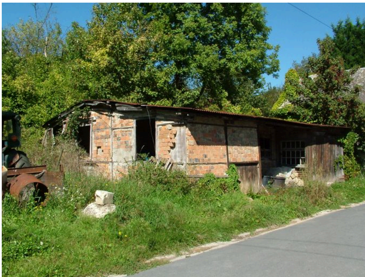
Restes d'une maison provisoire, 9 rue des Bons Enfants.
