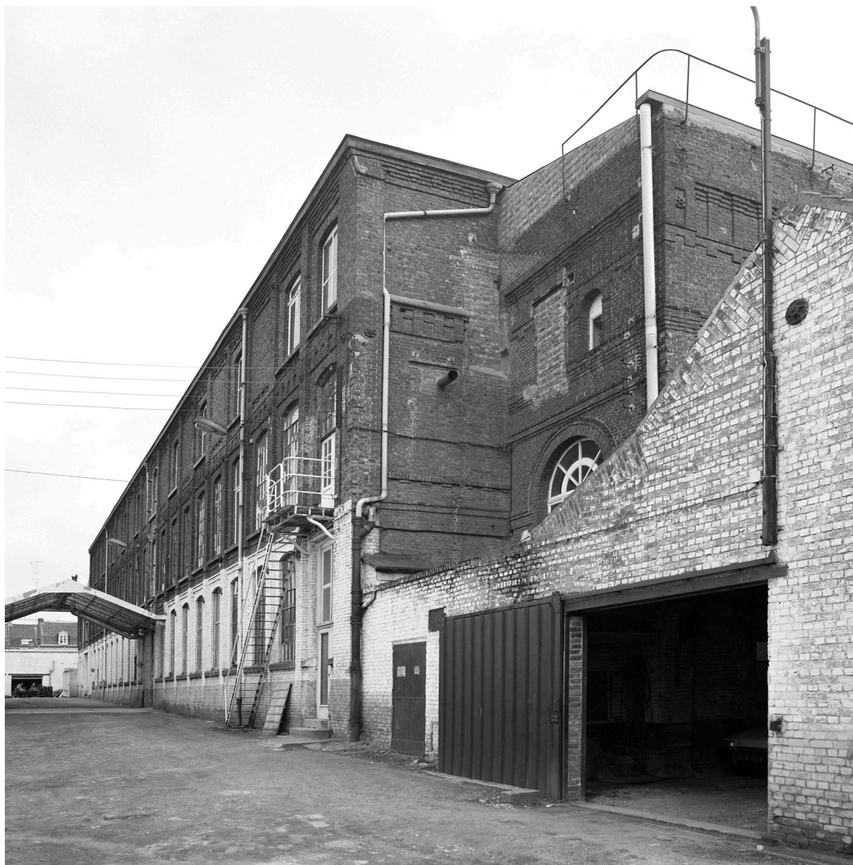
Salle des machines et atelier de fabrication.
