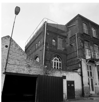
Atelier de fabrication, ancienne salle des machines. Phot. Philippe Dapvril IVR31_19885901276X
