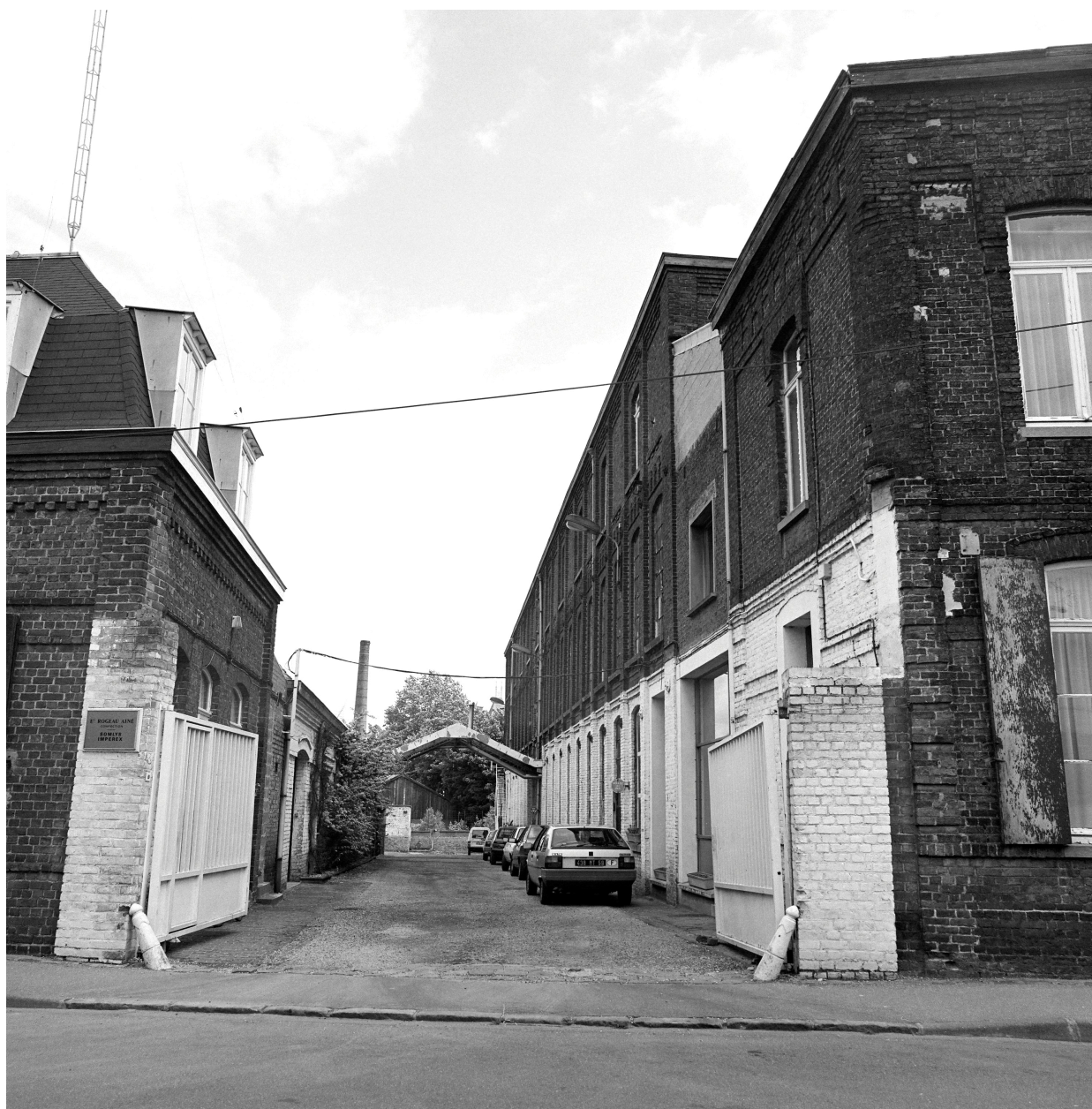
Entrée rue des Prés, à droite, atelier de fabrication, au fond, poste de chargement.
