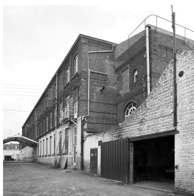
Salle des machines et atelier de fabrication. Phot. Philippe Dapvril IVR31_19885901277X
