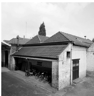
Magasin industriel, garage à vélos. Phot. Philippe Dapvril IVR31_19885901271X
