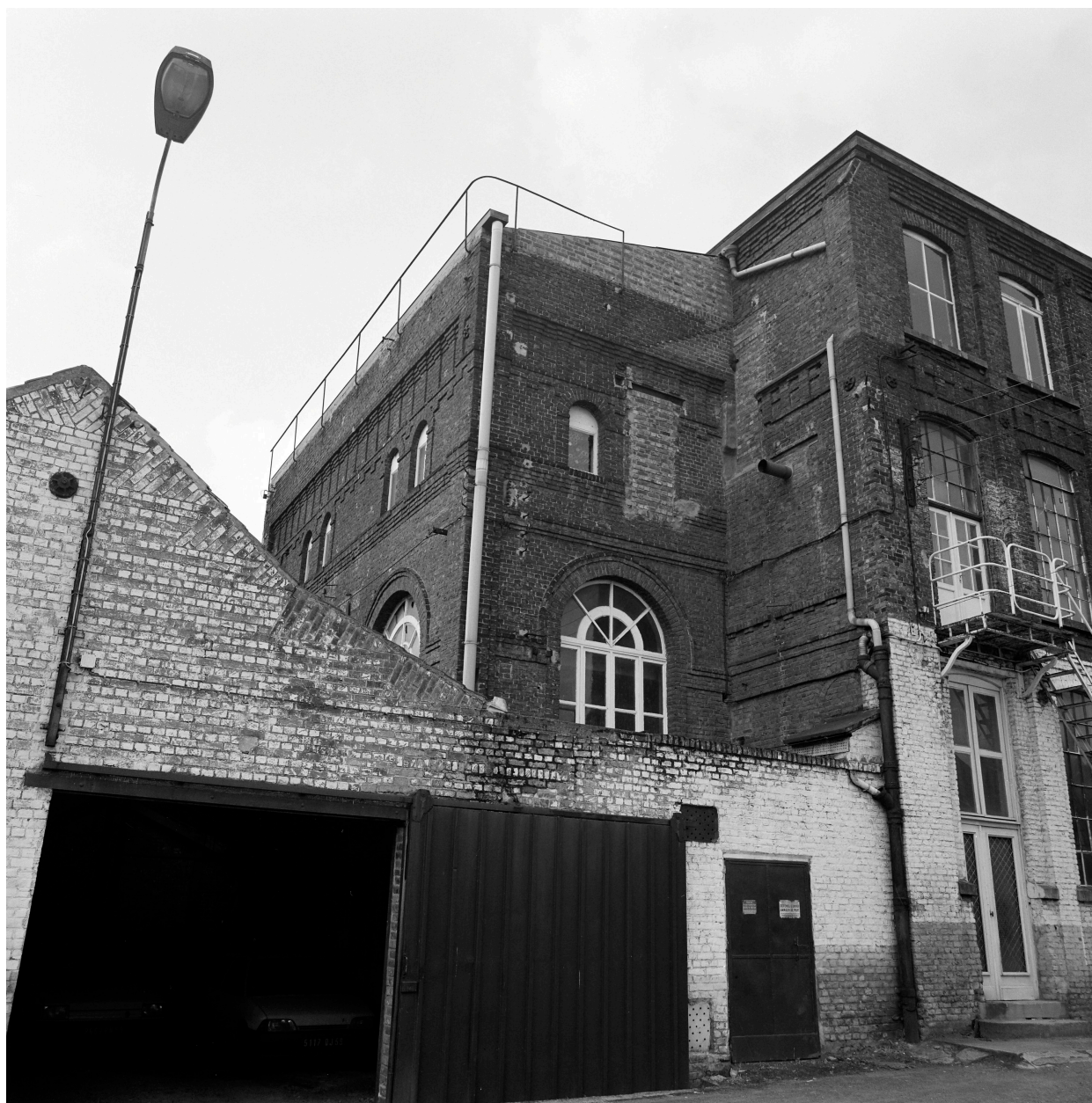
Atelier de fabrication, ancienne salle des machines.
