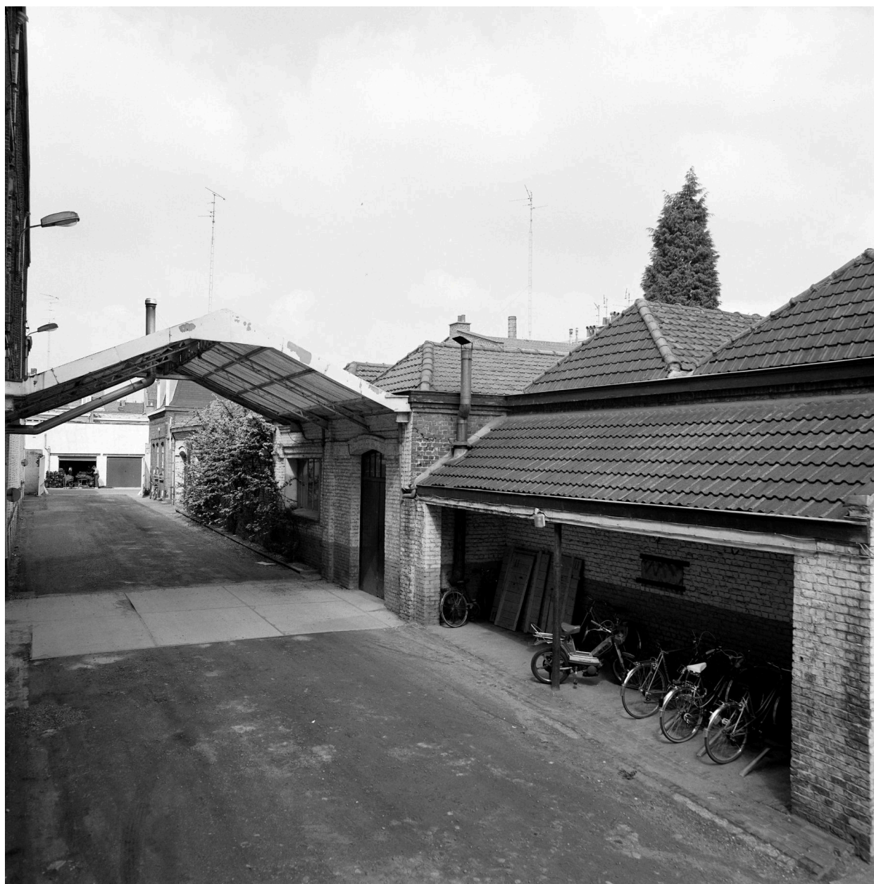
Magasin, poste de chargement.
