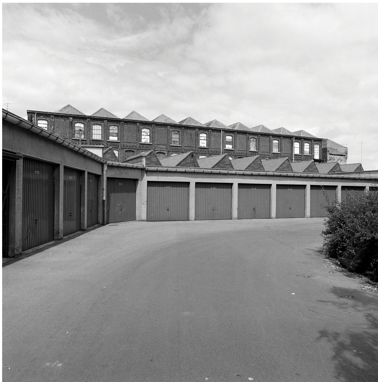
Atelier de fabrication, élévation sud.
