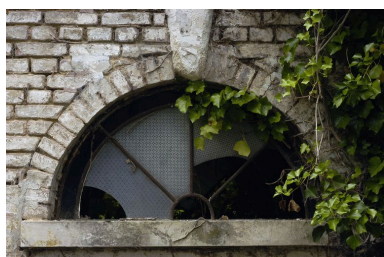
Vue d'une des verrières. Phot. Thierry Lefébure IVR22_20058001098NUCA
