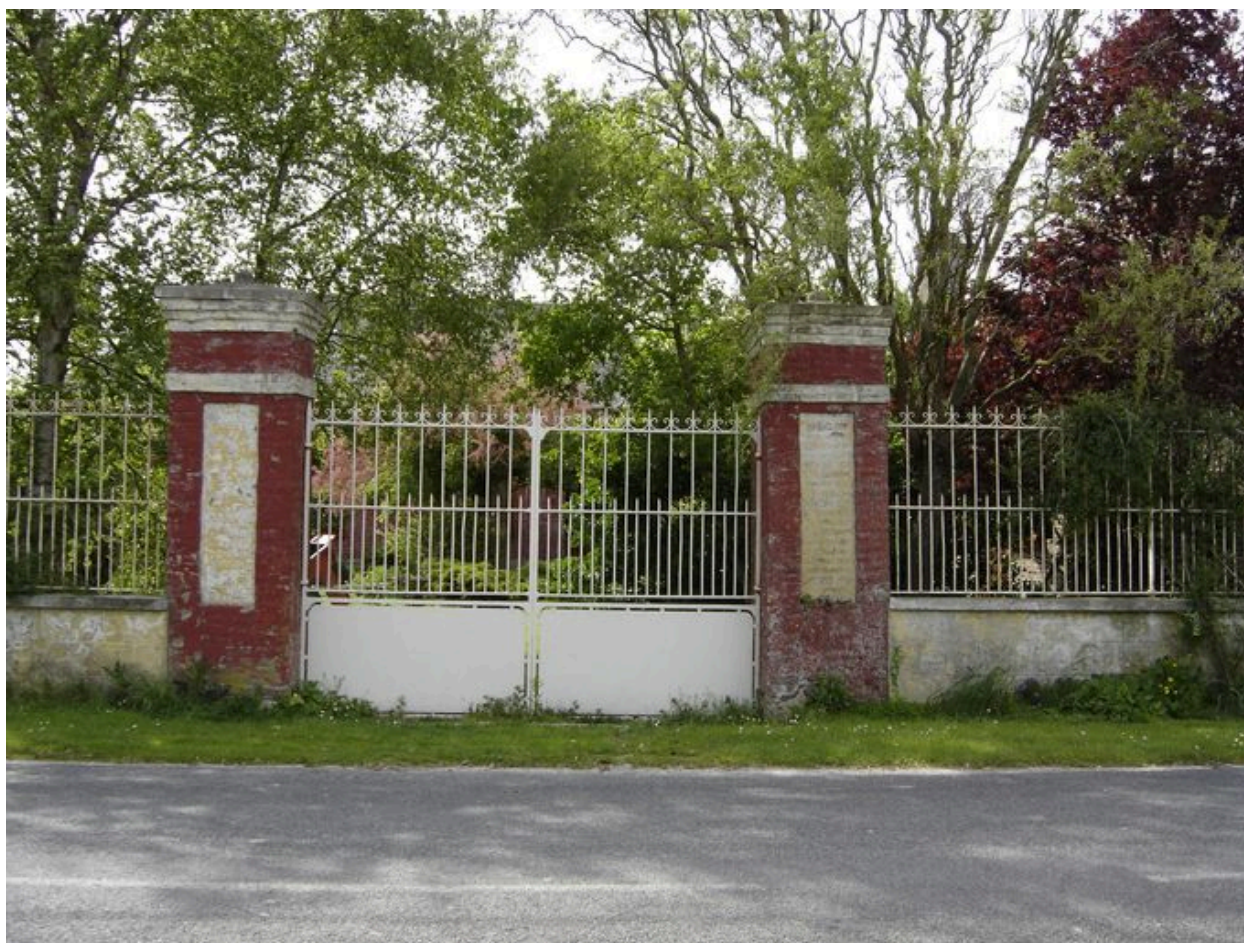
Vue de face de l'entrée.
