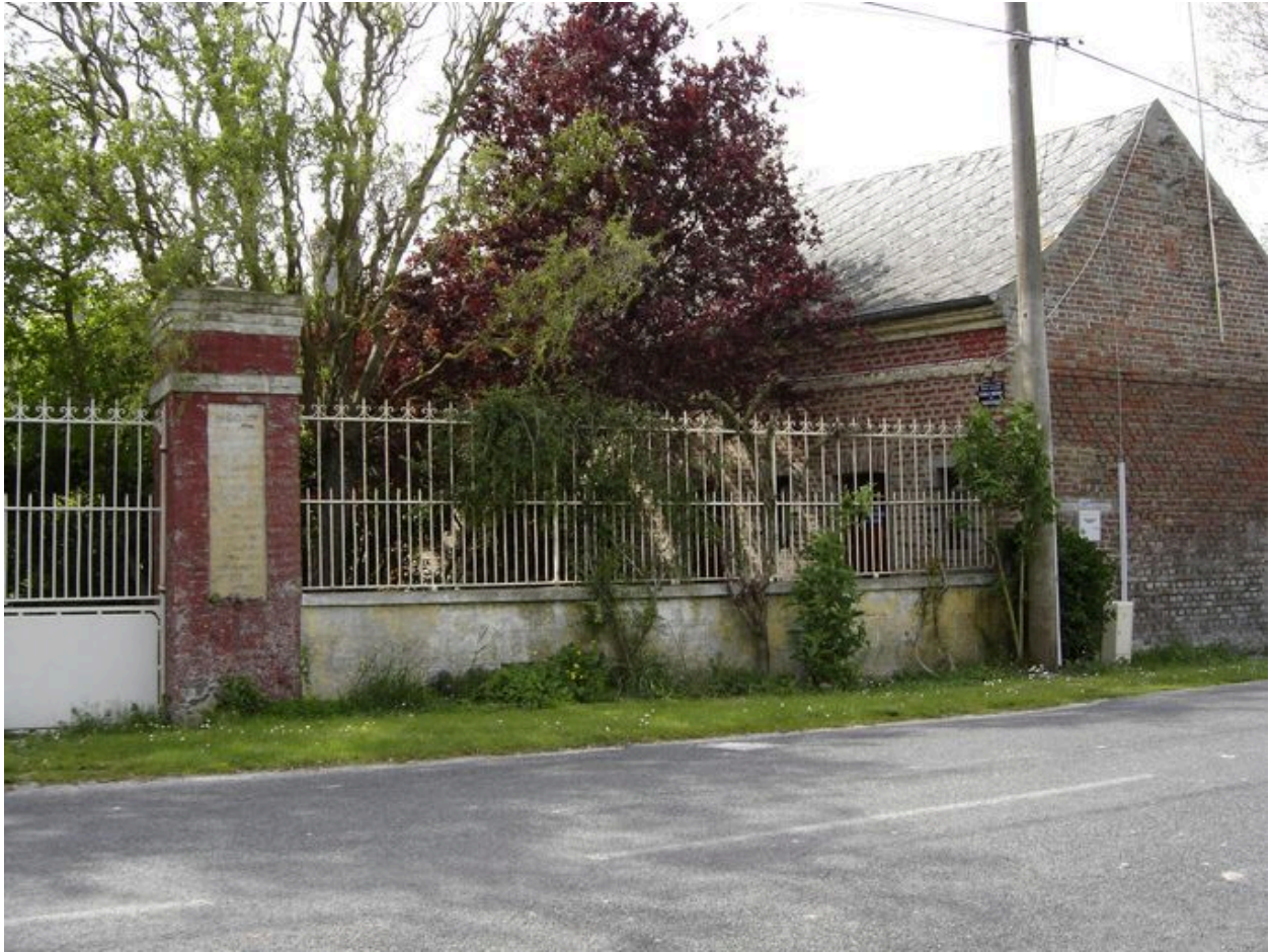
Vue sur le pignon du bâtiment nord.
