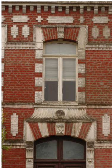
Détail sur la travée centrale. Phot. Thierry Lefébure IVR22_20038005207NUCA
