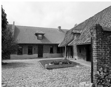
La cour : élévations antérieures du logis et des étables. Phot. Philippe Dapvril IVR31_20045900474X
