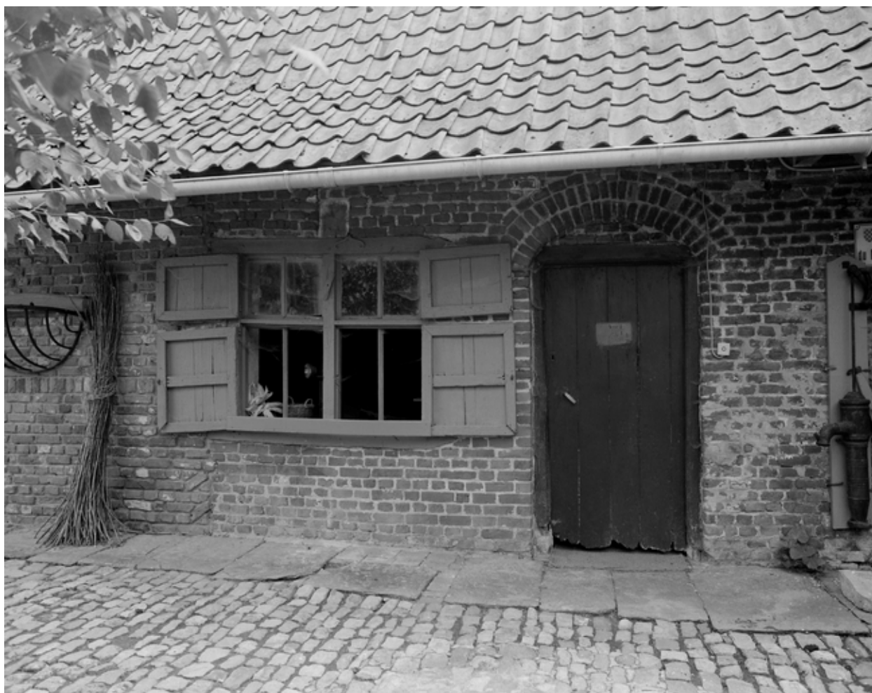
Entrée du logis primitif : la porte et la fenêtre à croisée en bois.
