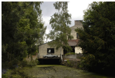
Vue du pignon de l'atelier de fabrication et du canal de fuite. Phot. Thierry Lefébure IVR22_20046000189NUCA
