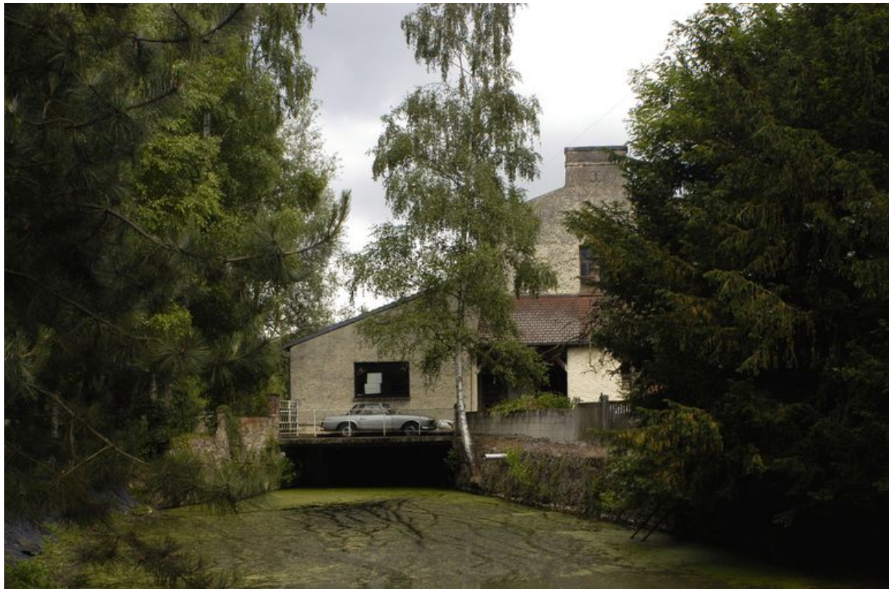
Vue du pignon de l'atelier de fabrication et du canal de fuite.
