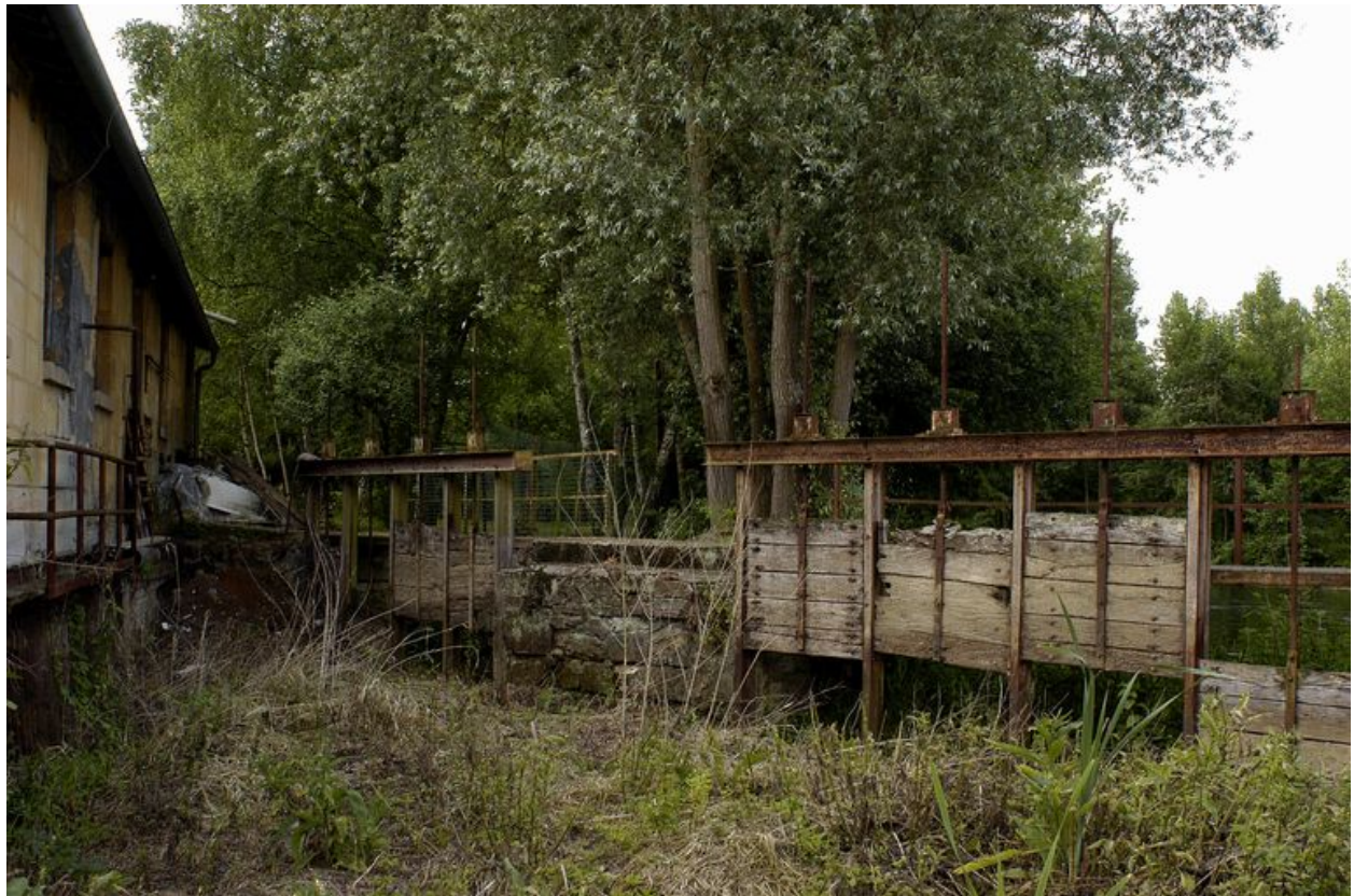
Vannage de décharge du canal d'amenée.
