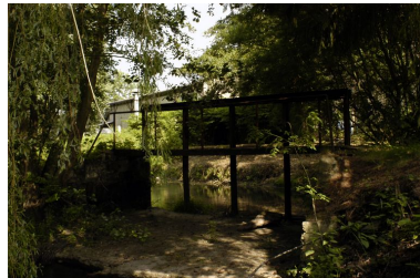
Vannage de décharge principal et déversoir. Phot. Thierry Lefébure IVR22_20046000199NUCA
