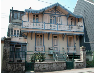
Vue d'ensemble depuis la rue. Phot. Elisabeth Justome IVR22_20058002540NUCA
