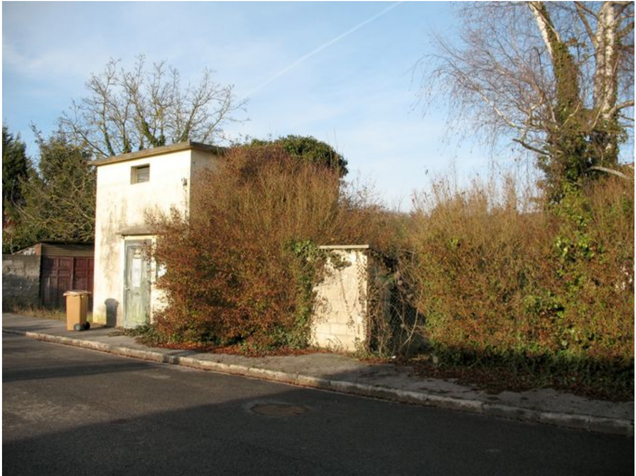
Le transformateur électrique le long de la rue Parot.
