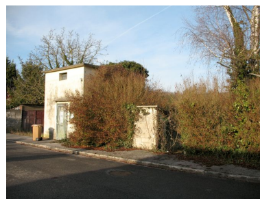
Le transformateur électrique le long de la rue Parot. Phot. Clarisse Lorieux IVR22_20096005028NUCA
