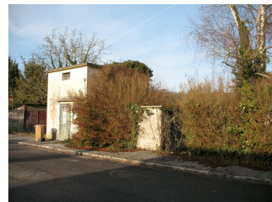
Le transformateur électrique le long de la rue Parot. Phot. Clarisse Lorieux IVR22_20096005028NUCA
