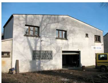
Le bâtiment principal construit pour la blanchisserie en 1959. Phot. Clarisse Lorieux IVR22_20096005027NUCA
