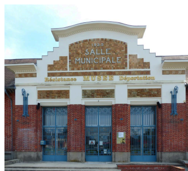
Vue de détail de la façade antérieure avec une inscription et une date portées. Phot. Isabelle Barbedor IVR32_20170205621NUCA
