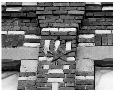
Atelier de fabrication, façade nord-ouest. Fer d'ancrage et décor de brique. Phot. Olivier Marlard IVR31_19885901965X
