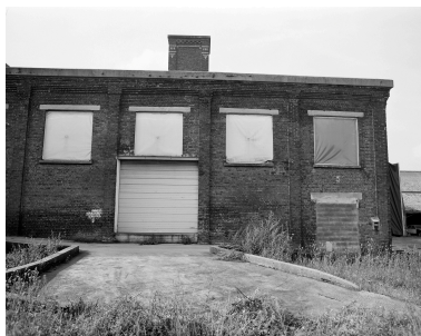
Ancienne chaufferie, rampe d'accès. Phot. Olivier Marlard IVR31_19885901882X
