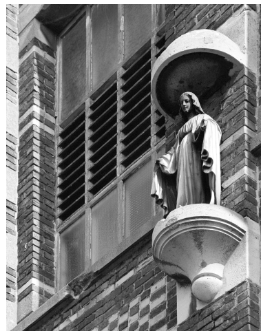
Statue de la Vierge sur la tour d'escalier. Phot. Philippe Dapvril IVR31_19885901991X
