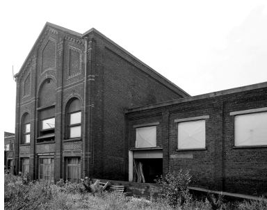
Ancienne salle des machines. Vue prise vers le sud. Phot. Olivier Marlard IVR31_19885901883X
