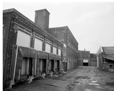
Enfilade vers le sud-ouest, entre l'atelier de fabrication et les magasins industriels. Phot. Olivier Marlard IVR31_19885901881X
