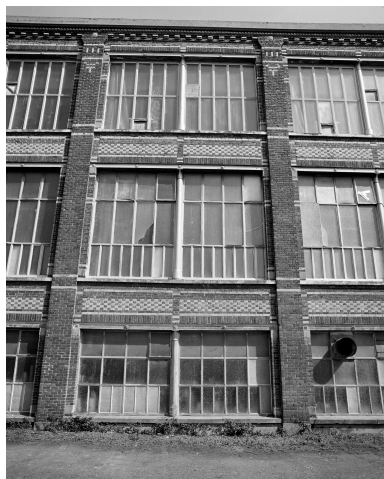
Atelier de fabrication. Une travée. Phot. Philippe Dapvril IVR31_19885901967X
