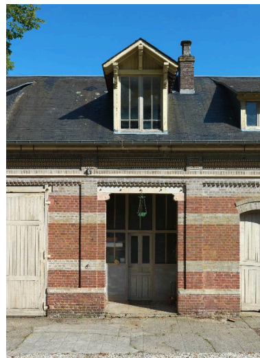
Détail de l'entrée de la dépendance. Phot. Thierry Lefébure IVR22_20148000445NUC2A
