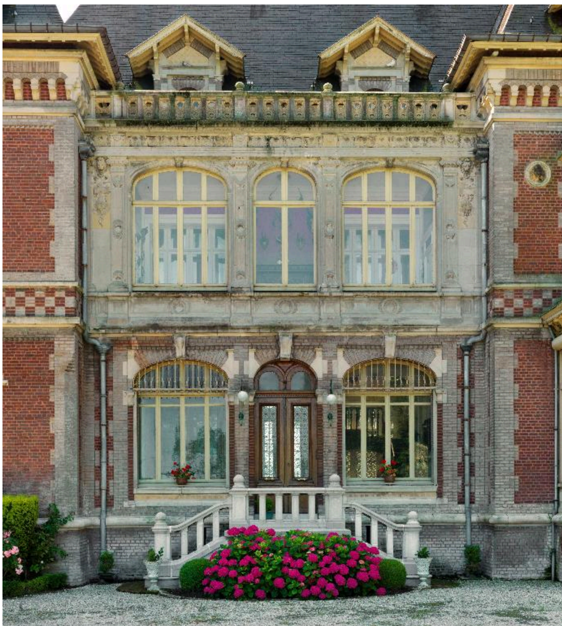
Détail de la façade principale.
