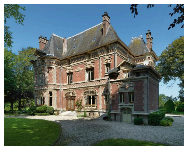
Façade postérieure. Phot. Thierry Lefébure IVR22_20148000440NUC2A
