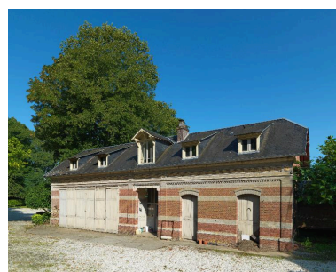
Vue générale de la dépendance et des garages. Phot. Thierry Lefébure IVR22_20148000444NUC2A
