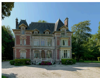
Façade principale. Phot. Thierry Lefébure IVR22_20148000438NUC2A
