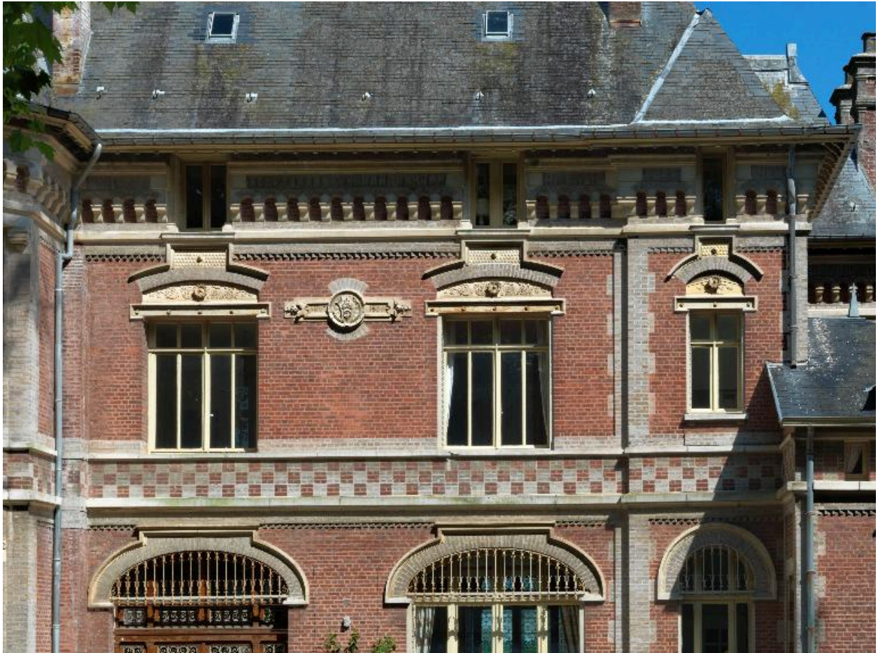
Détail de la façade postérieure.
