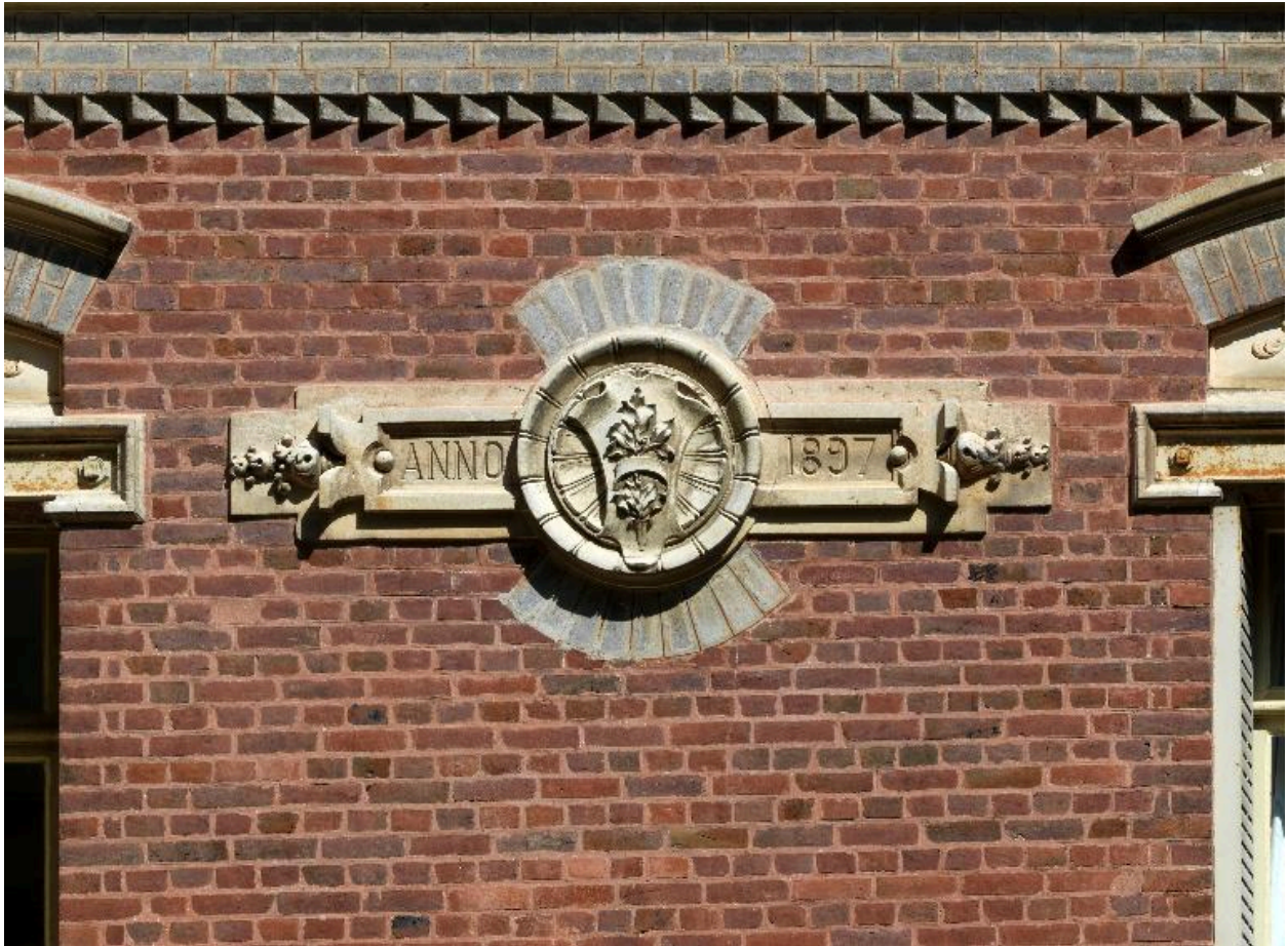
Détail du cartouche de la façade postérieure portant la date de 1897.
