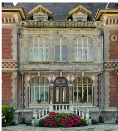
Détail de la façade principale. Phot. Thierry Lefébure IVR22_20148000439NUC2A
