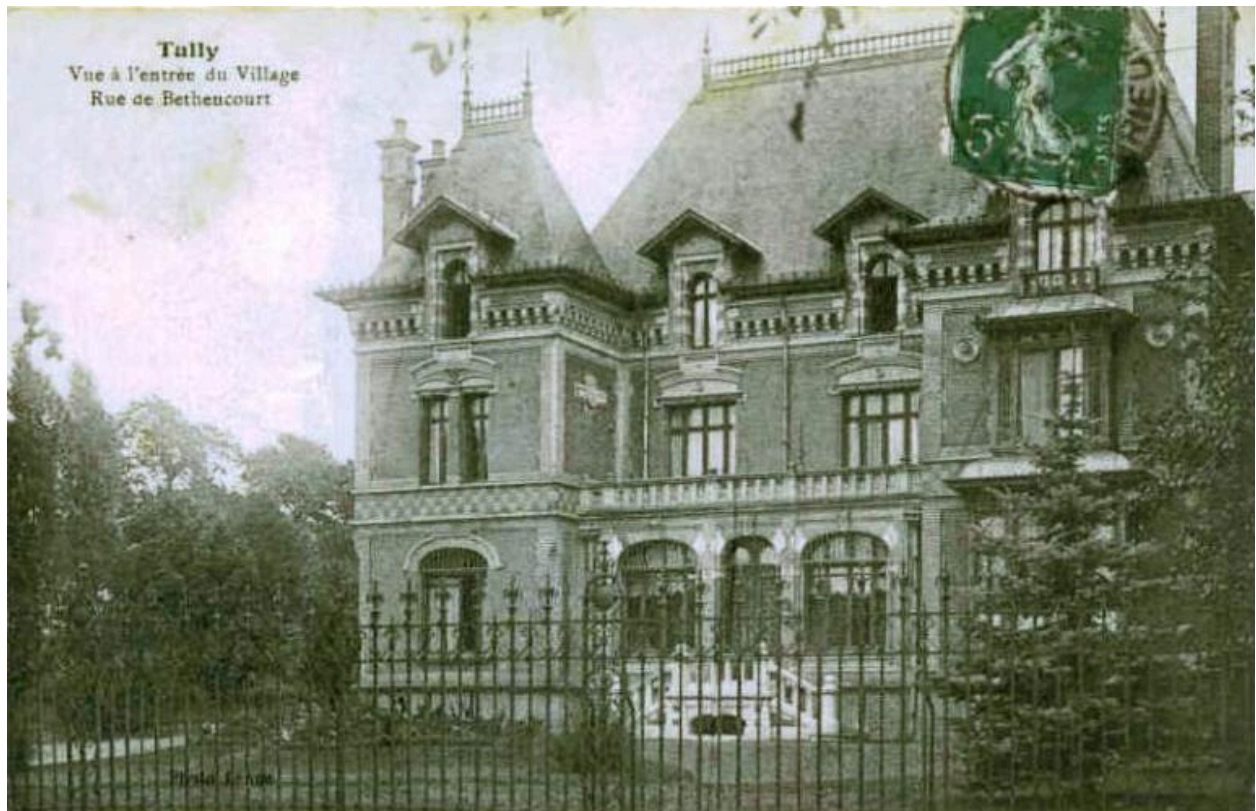
Vue générale du château Buiret, vers 1905 (coll. part.).
