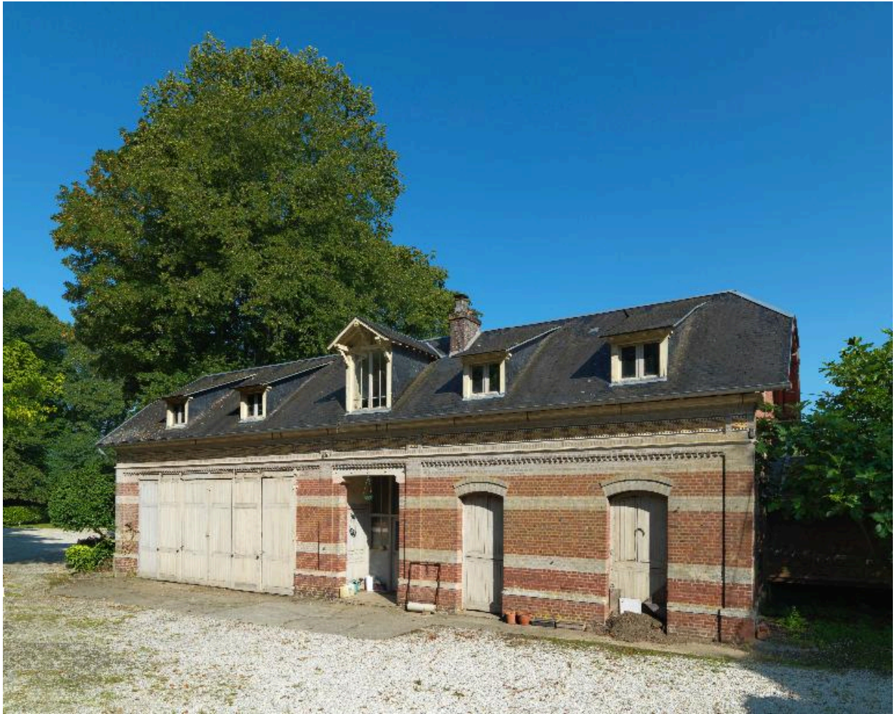
Vue générale de la dépendance et des garages.
