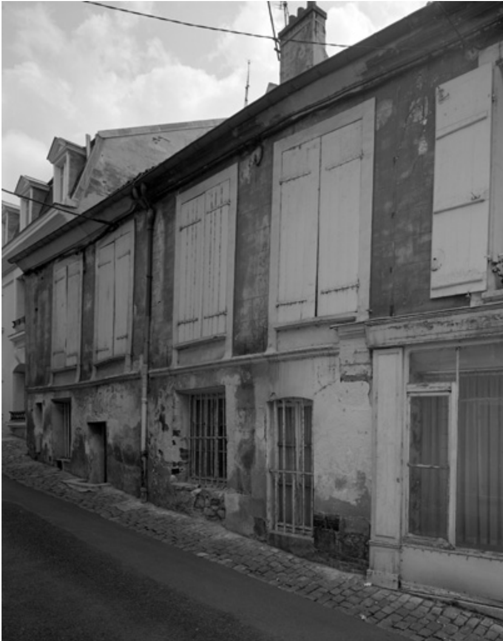
Vue de la façade sur la rue avec la boutique au premier plan.
