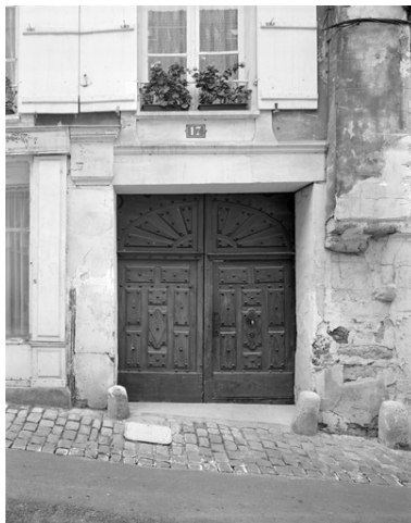
Le portail. Phot. Thierry Lefébure IVR22_19940201137V
