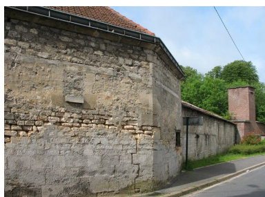
Détail des bâtiments. Phot. Clarisse Lorieux IVR22_20096005034NUCA
