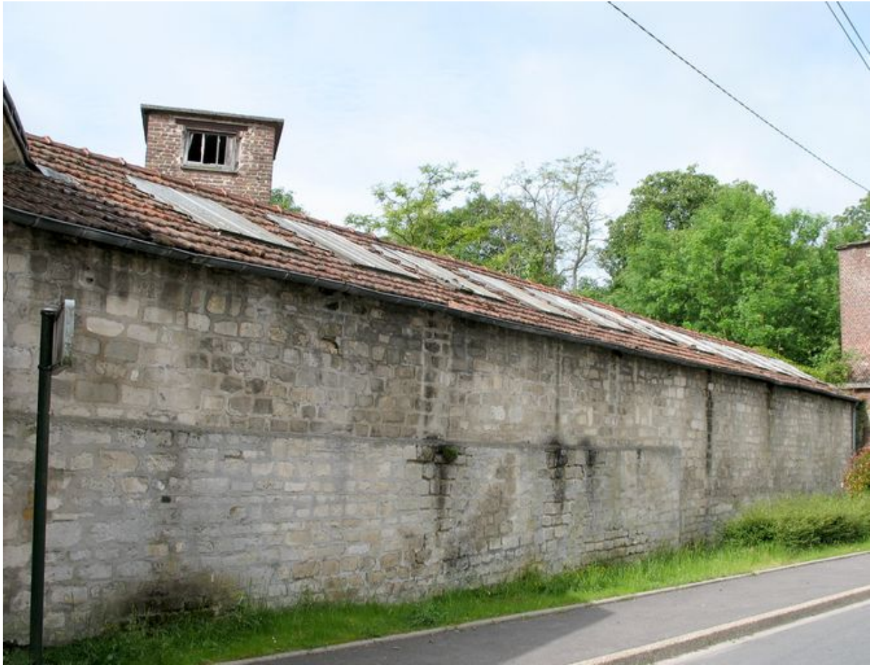
Bâtiment sur la commune de Monchy-Saint-Eloi abritant les ateliers.
