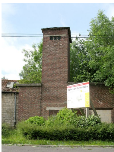
Transformateur électrique construit sur la commune de Monchy-Saint-Eloi. Phot. Clarisse Lorieux IVR22_20096005035NUCA
