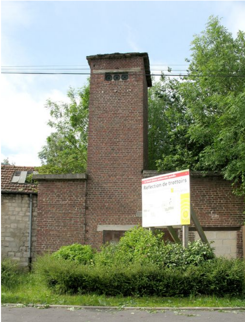
Transformateur électrique construit sur la commune de Monchy-Saint-Eloi.
