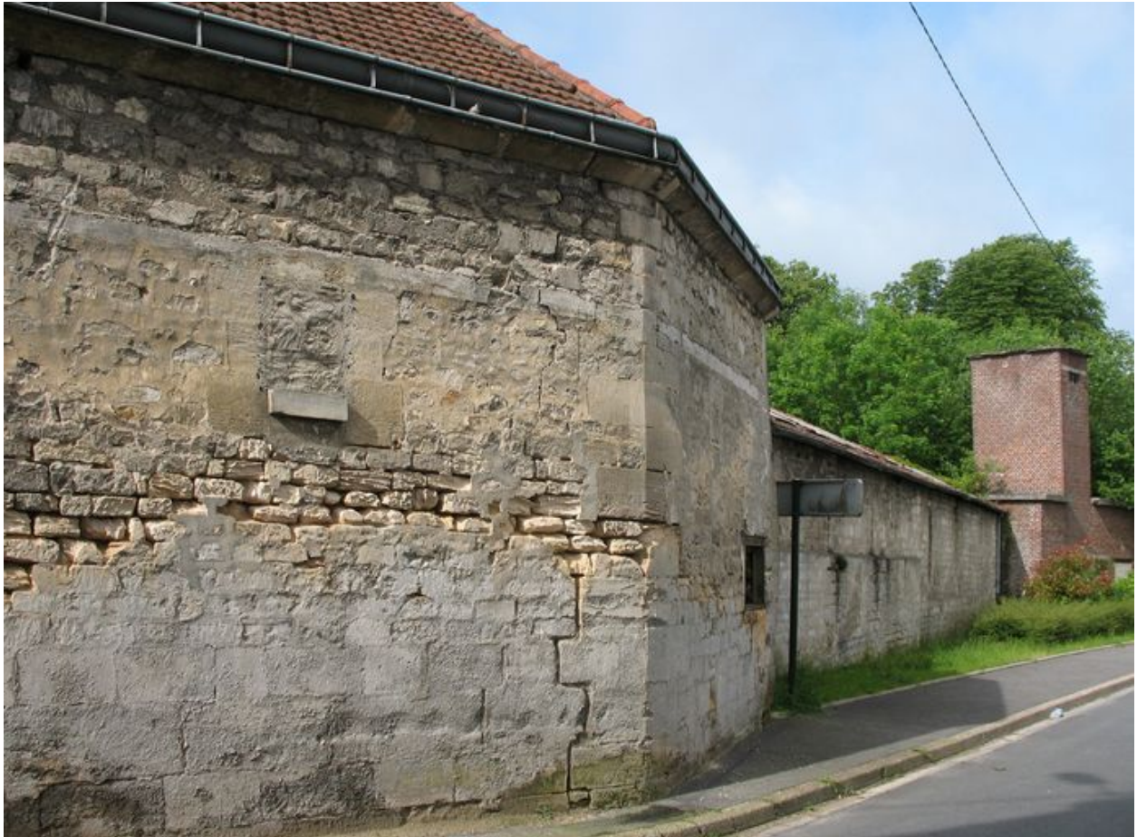
Détail des bâtiments.
