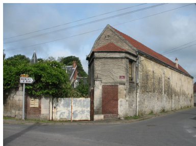
Les bâtiments de la Moulinière depuis la rue Marcel Deneux. Phot. Clarisse Lorieux IVR22_20096005031NUCA
