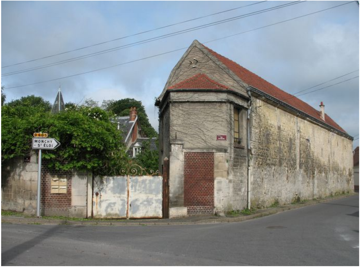
Les bâtiments de la Moulinière depuis la rue Marcel Deneux.
