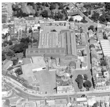
Vue aérienne, flanc sud. Phot. Phot'R IVR22_19888001227P
