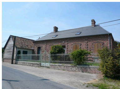
Vue du logis. Phot. Inès Guérin IVR22_20078005713NUCA
