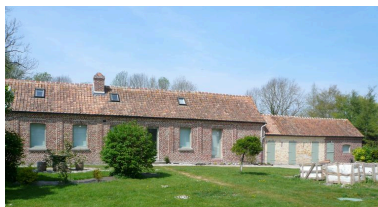
Vue des étables au sud-ouest. Phot. Inès Guérin IVR22_20078005714NUCA
