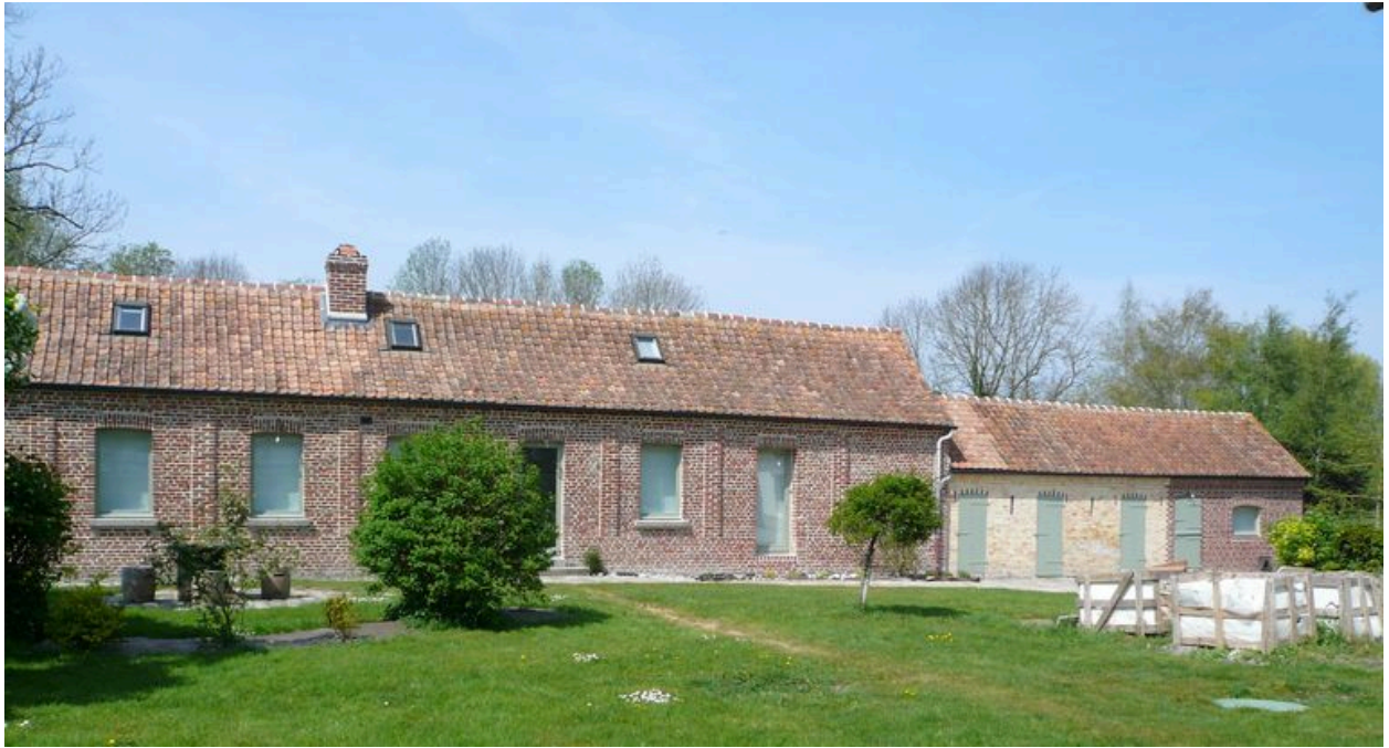
Vue des étables au sud-ouest.
