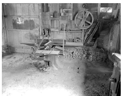
Machine à découper et scier le bois. Phot. Laurent Jumel IVR22_19980201029X
