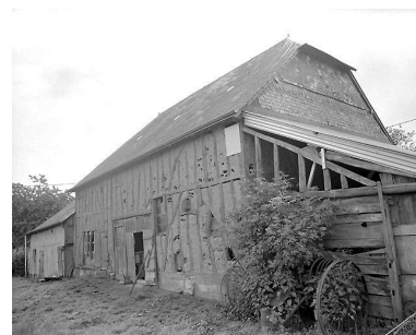
Élévation postérieure du logis et de la grange-étable. Phot. Laurent Jumel IVR22_19980201025X
