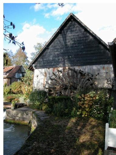
Le pignon du moulin portant la structure métallique de la roue hydraulique.
