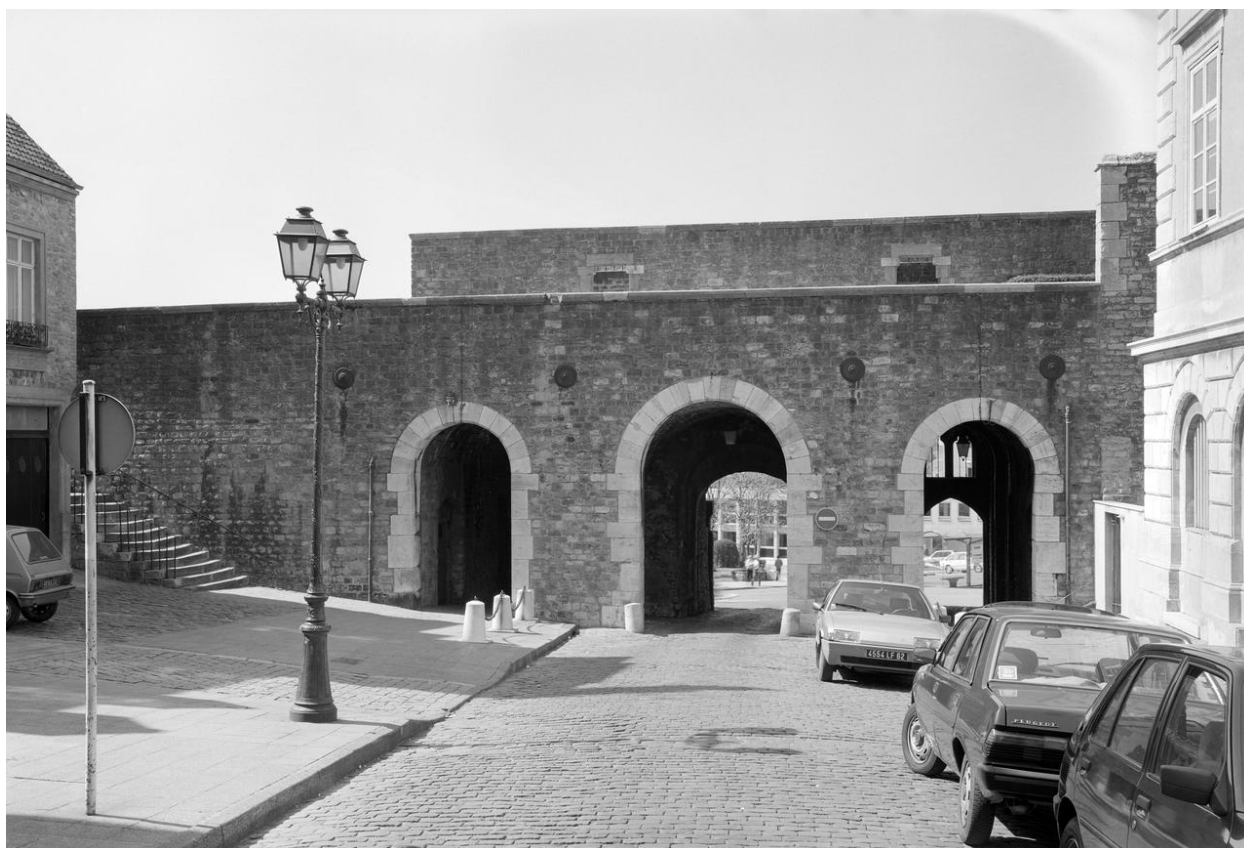
Vue générale sur place.
