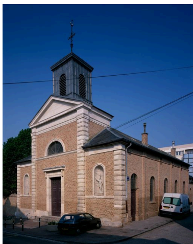
Vue générale. Phot. Thierry Lefébure IVR22_20038000387VA
