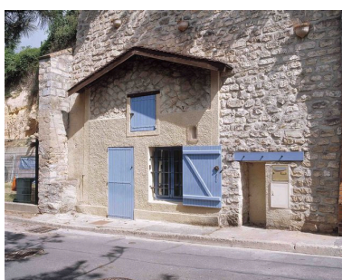
Habitation troglodytique rue des Hauts-Tufs à Creil. Phot. Thierry Lefébure IVR22_20076000056XA
