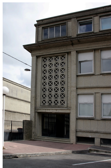
Détail de la façade des services sociaux. Phot. Frédéric Pillet IVR22_20040200833NUCA
