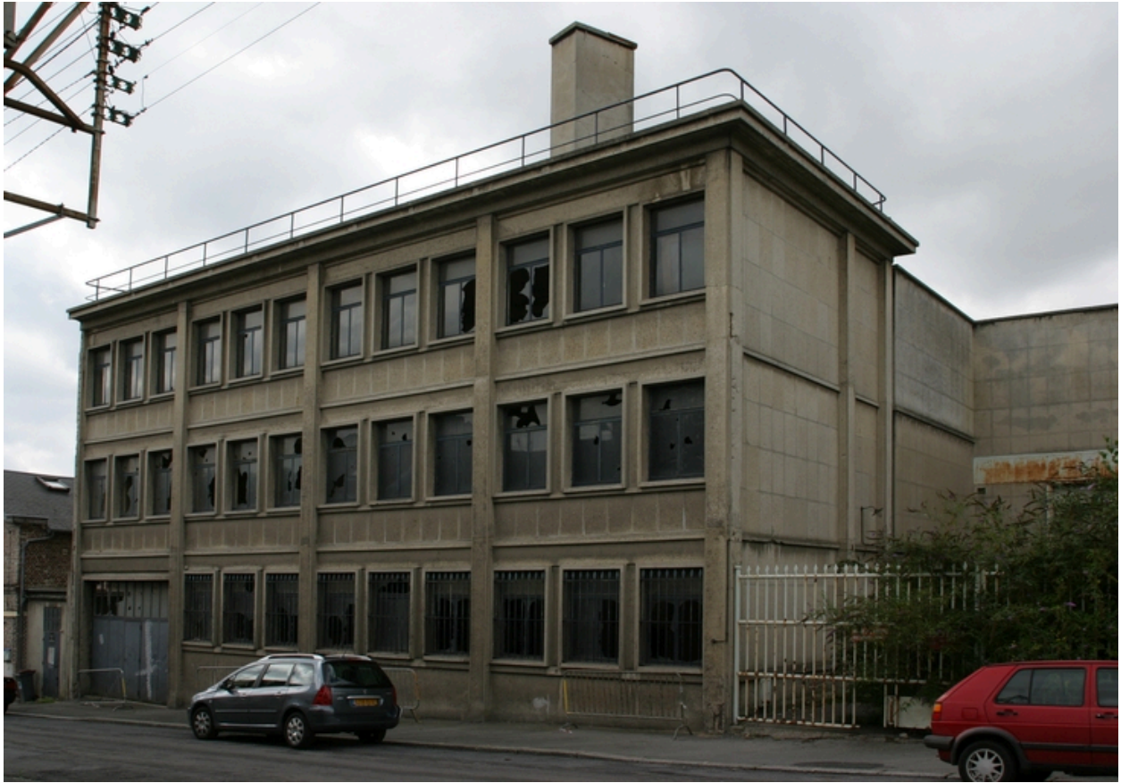
Façade antérieure de la chaufferie, rue Jacquard.
