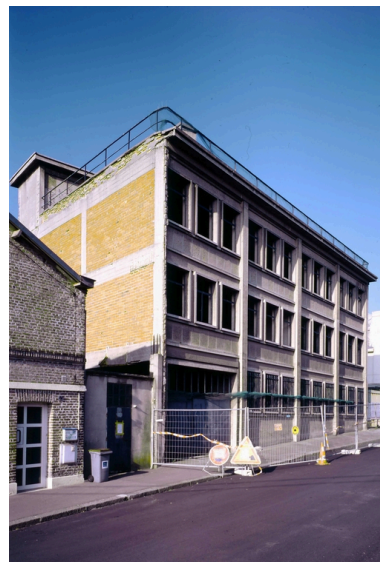
Façade antérieure de la chaufferie, rue Jacquard. Phot. Thierry Lefébure IVR22_20070200078XA
