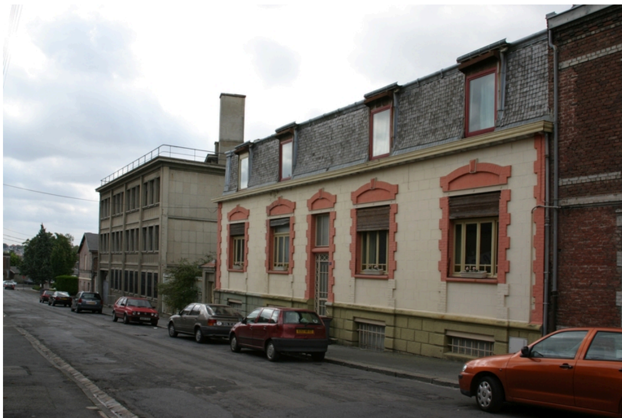
Logement patronal et chaufferie, rue Jacquard.
