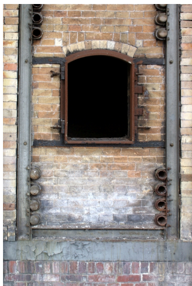
Vestiges de l'une des deux chaudières de la chaufferie. Phot. Frédéric Pillet IVR22_20040200837NUCA
