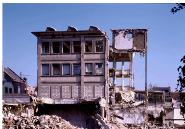
Vue de l'usine en cours de démolition. Phot. Thierry Lefébure IVR22_20070200079XA
