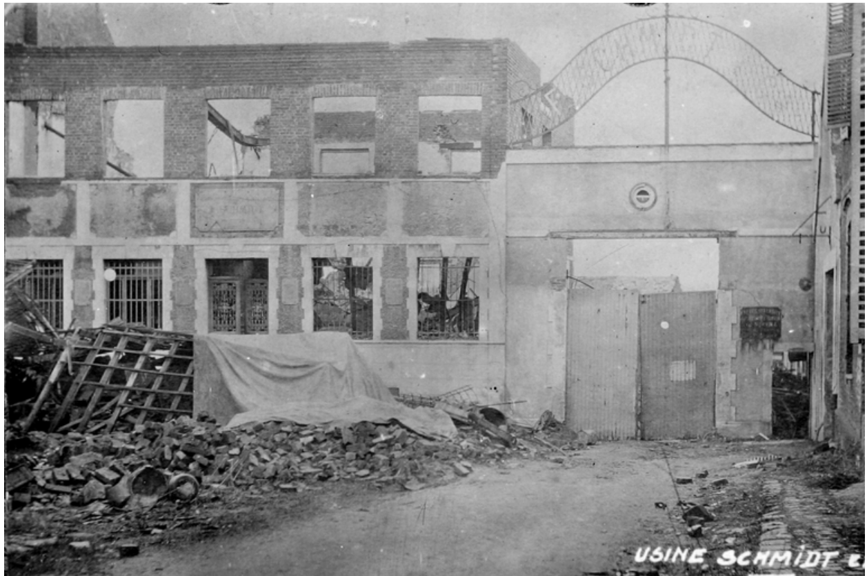
Usine Schmidt & Cie - Entrée principale et bureaux - (reproduction d'une photographie remise par M. Schmidt en 1919) - Brassart-Mariage architecte (AD Aisne).
