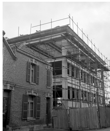
Les services généraux en construction, vers 1950 (IFA). Phot. Pillet Frédéric IVR22_20040201164NUCAB
