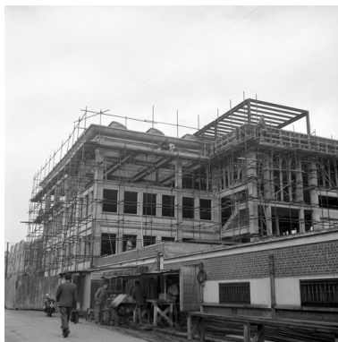
Les services généraux en construction : façade antérieure, vers 1950 (IFA). Phot. Pillet Frédéric IVR22_20040201163NUCAB
