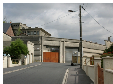
Le site vu depuis la rue Lecat, à l'angle de la rue de Crimée : le mur-écran construit en 1962 pour masquer les sheds des ateliers, aujourd'hui détruits. Phot. Frédéric Pillet IVR22_20040200830NUCA
