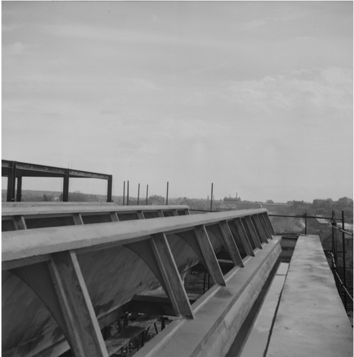
Les sheds des services généraux, vers 1950 (IFA).
