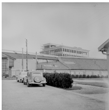
Les services généraux en construction, vus depuis la rue Lecat, vers 1950 (IFA). Phot. Pillet Frédéric IVR22_20040201165NUCAB
