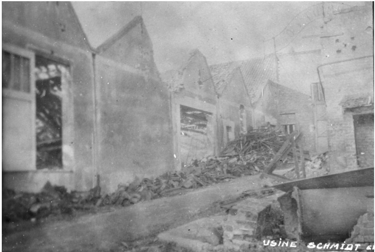
Usine Schmidt & Cie - Bâtiment de montage des tours (vue extérieure) - (reproduction d'une photographie remise par M. Schmidt en 1919) - Brassart-Mariage architecte (AD Aisne).
