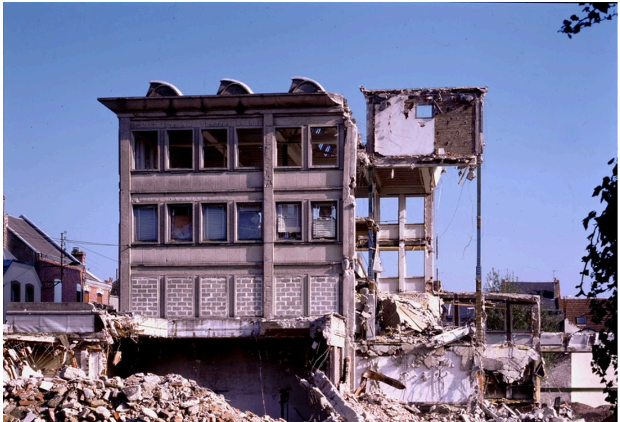
Vue de l'usine en cours de démolition.
