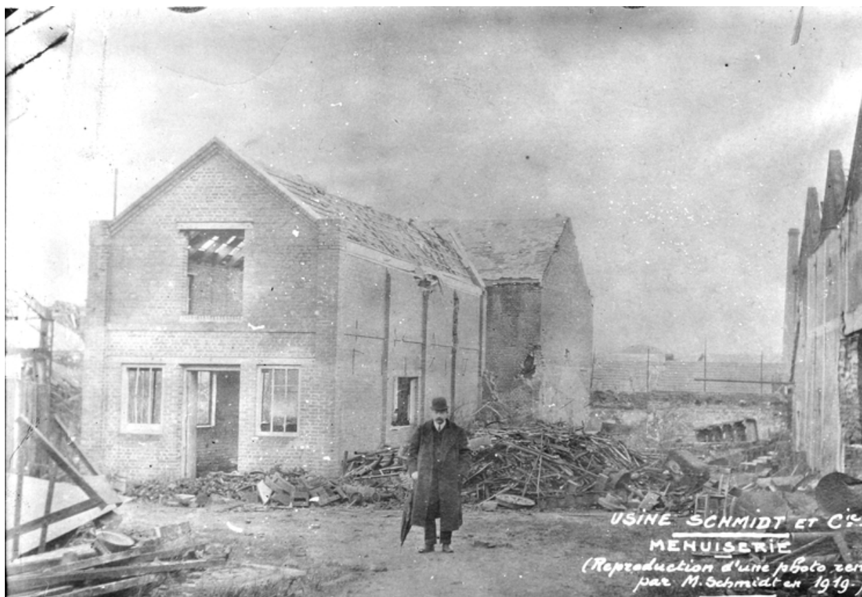
Usine Schmidt & Cie - Menuiserie - (reproduction d'une photographie remise par M. Schmidt en 1919) - Brassart-Mariage architecte (AD Aisne).
