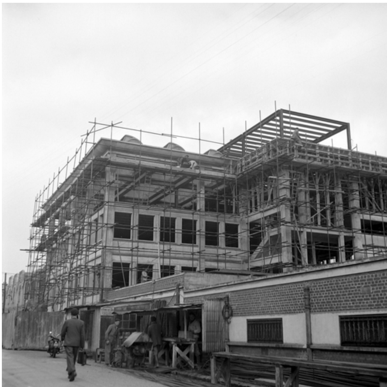
Les services généraux en construction : façade antérieure, vers 1950 (IFA).
