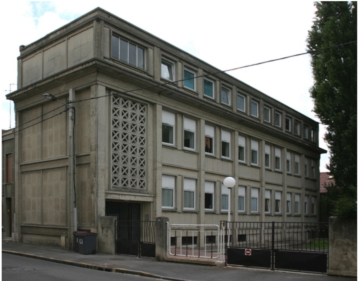
Façade antérieure des services sociaux.
