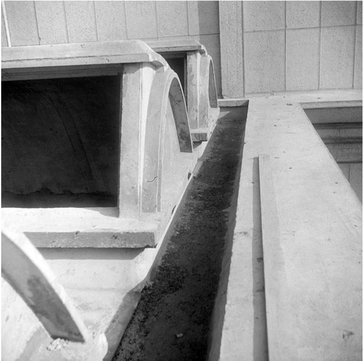
Les sheds des services généraux, vers 1950 (IFA).
