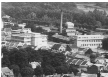
Les Etablissements Boyer vus de l'ouest. A l'arrière-plan, la brasserie La Populaire et sa grande cheminée, vers 1950-1964 (AD Aisne). Phot. Pillet Frédéric IVR22_20040200819NUCAB
