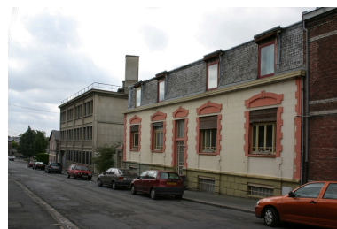
Logement patronal et chaufferie, rue Jacquard. Phot. Frédéric Pillet IVR22_20040200839NUCA
