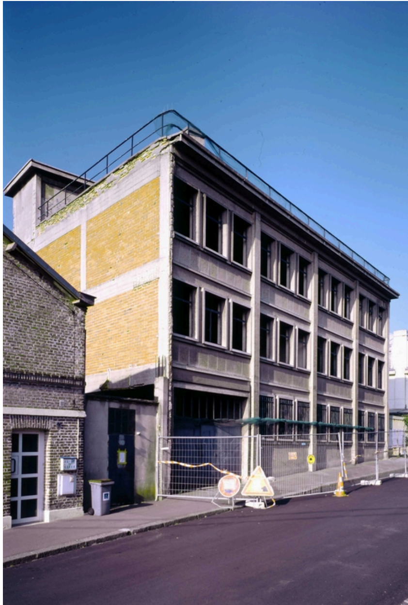
Façade antérieure de la chaufferie, rue Jacquard.
