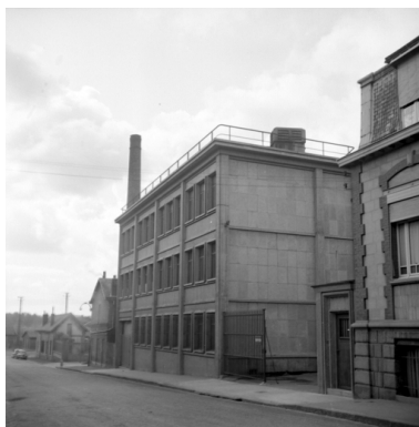
La chaufferie achevée, vers 1950 (IFA). Phot. Pillet Frédéric IVR22_20040201158NUCAB
