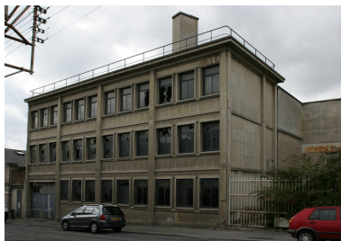
Façade antérieure de la chaufferie, rue Jacquard. Phot. Frédéric Pillet IVR22_20040200835NUCA
