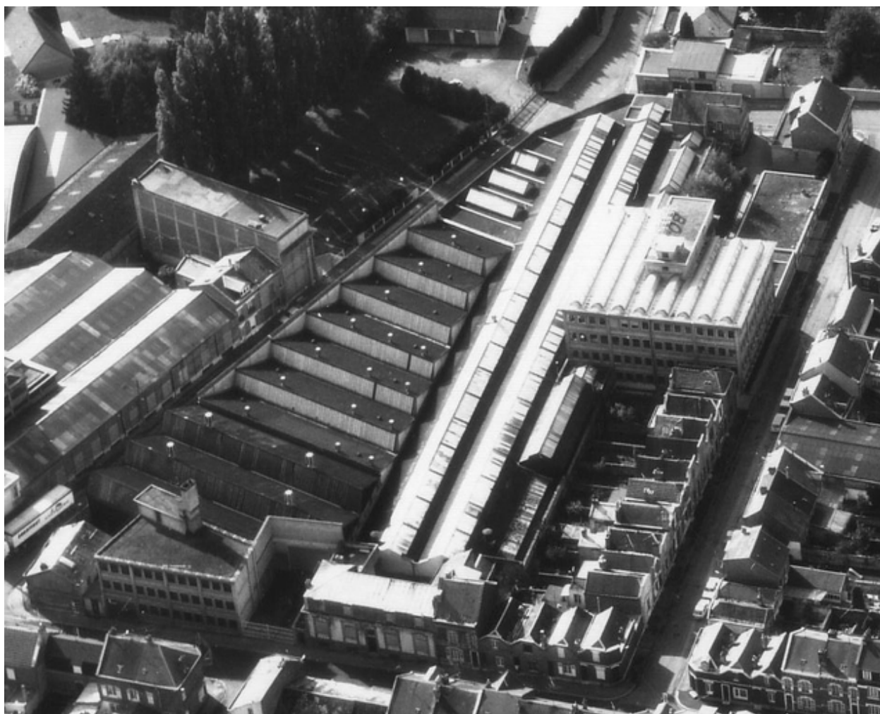
Les Etablissements Boyer vus de l'est en 1989.
