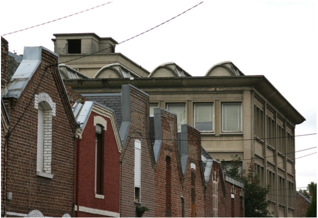
Les services généraux vus depuis l'intersection des rues Claude-Debussy et Jacquard.
