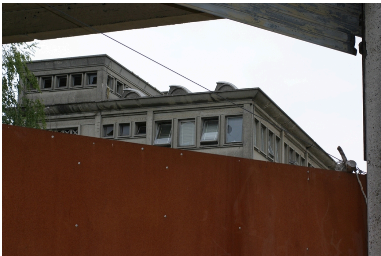
Les services généraux vus depuis l'ancienne entrée des ateliers.
