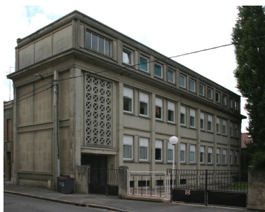
Façade antérieure des services sociaux. Phot. Frédéric Pillet IVR22_20040200832NUCA
