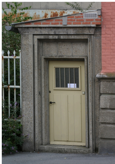
Entrée piétonne accolée au logement patronal, rue Jacquard. Phot. Frédéric Pillet IVR22_20040200840NUCA
