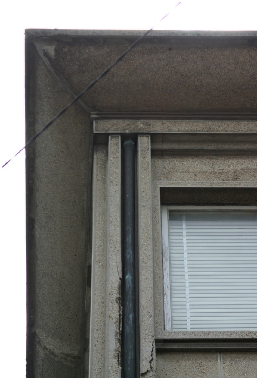
Détail de la façade (rue Claude-Debussy) des services généraux.
