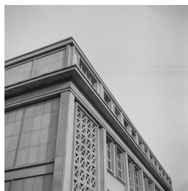
Détail de la façade des services sociaux, vers 1950 (IFA). Phot. Pillet Frédéric IVR22_20040201160NUCAB
