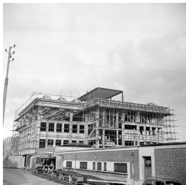
Les services généraux en construction : façade antérieure, vers 1950 (IFA). Phot. Pillet Frédéric IVR22_20040201162NUCAB
