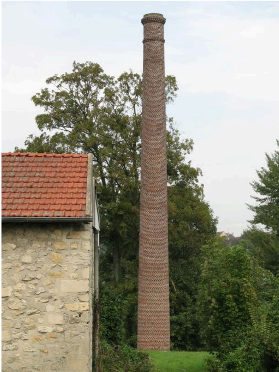
Cheminée de la machine à vapeur.
