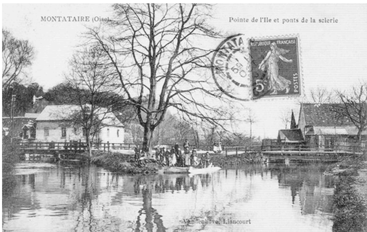
A droite, la scierie d'acajou et à gauche un moulin à blé, début 20e siècle (AC Montataire).
