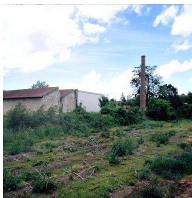
Cheminée d'évacuation des fumées et ateliers de l'usine de lacets. Phot. Thierry Lefébure IVR22_20076000081XA
