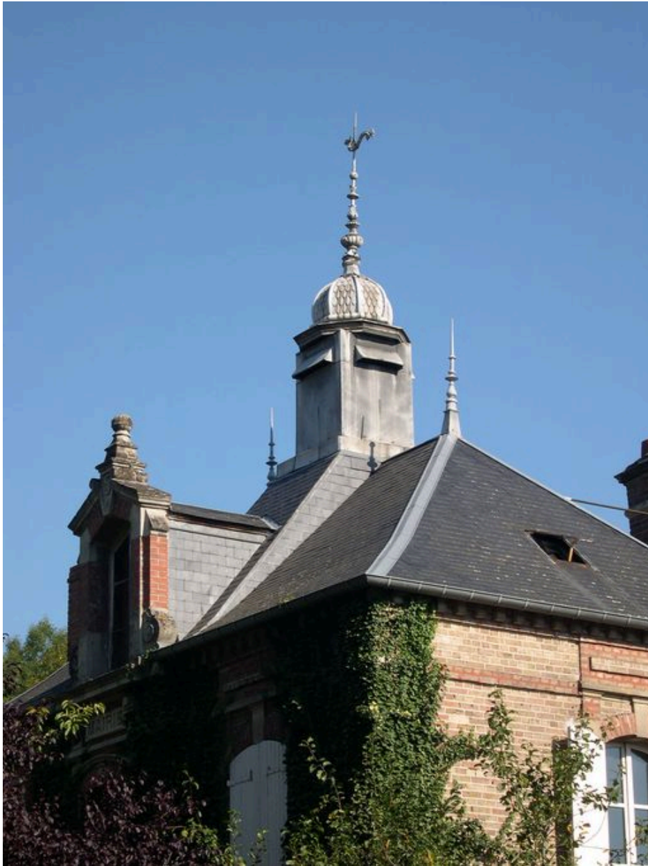
Détail sur le lanternon.
