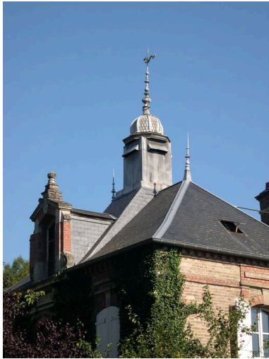
Détail sur le lanternon. Phot. Isabelle Barbedor IVR22_20038010733NUCA
