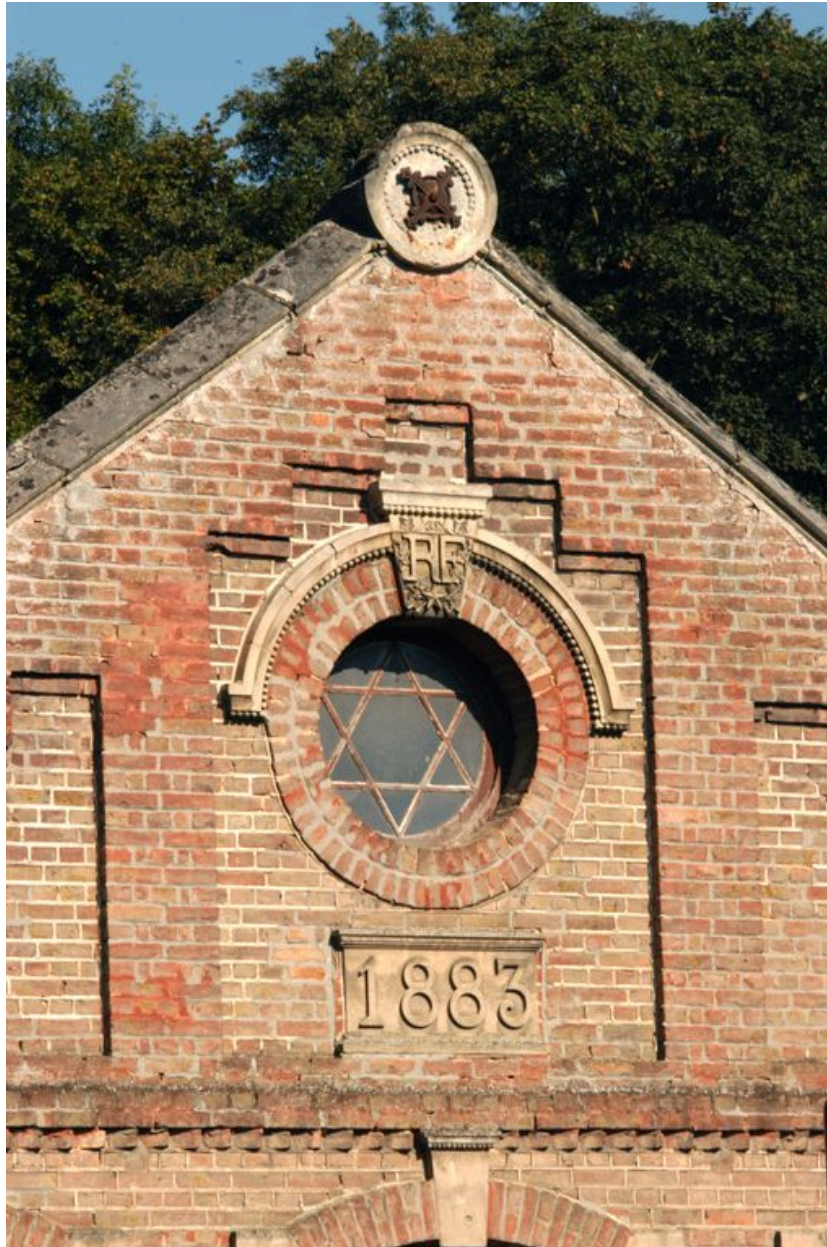
Détail sur le fronton et la date portée.
