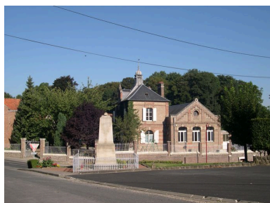
Vue de situation, depuis le sud-est. Phot. Isabelle Barbedor IVR22_20038010731NUCA
