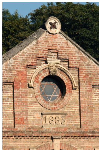
Détail sur le fronton et la date portée. Phot. Thierry Lefébure IVR22_20038000894NUCA
