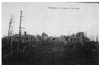
Ruines du bâtiment du grand commun, après 1916 ? (Historial de la Grande Guerre, Péronne ; n° 20993). Phot. Gilles-Henri Bailly (reproduction) IVR22_20158005192NUCA
