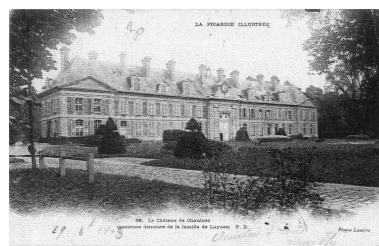
Bâtiment du grand commun dit "le Château", avant 1914 (Historial de la Grande Guerre, Péronne ; n° 20992). Phot. Gilles-Henri Bailly (reproduction) IVR22_20158005191NUCA
