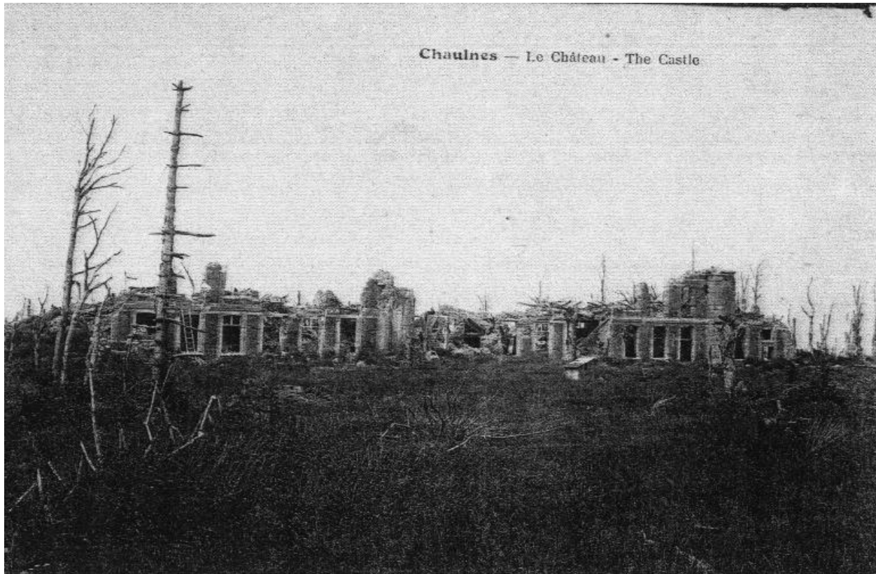
Ruines du bâtiment du grand commun, après 1916 ? (Historial de la Grande Guerre, Péronne ; n° 20993).
