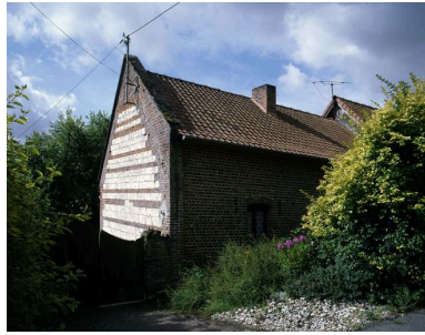
Pernois, pignon du logis de ferme, 322 rue d'En-Haut, portant la date de 1847. Phot. Marie-Laure Monnehay-Vulliet IVR22_20098000252XA
