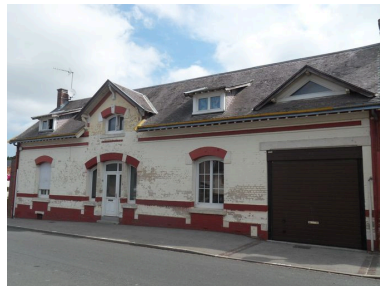
Saint-Ouen, maison, 9 rue Philippe-Louis, reconstruite vers 1838. Phot. Isabelle Barbedor IVR22_20108001535NUCA
