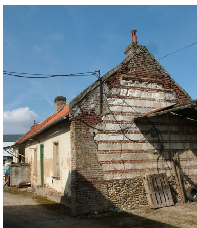
Havernas, pignon en brique et pierre d'un ancien logis de ferme, impasse Gaston-Moutardier, début du 19e siècle. Phot. Frédéric Fournis IVR22_20108001098NUCA
