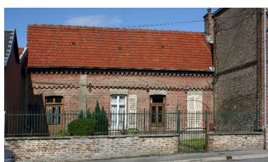
Flixecourt, maison, 5 rue Malakoff, portant la date de 1865. Phot. Bertrand Fournier IVR22_20138016099NUC2A
