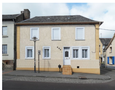
Saint-Ouen, maison, 9 rue de la République, reconstruite vers 1855. Phot. Isabelle Barbedor IVR22_20108001528NUCA
