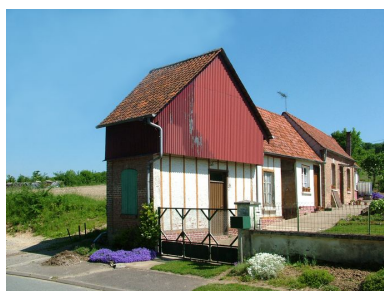
Franqueville, ancienne ferme, 37 rue de Berneuil, 2e moitié du 19e siècle, ayant perdu sa grange et son passage charretier sur rue. Phot. Frédéric Fournis IVR22_20108001792NUCA
