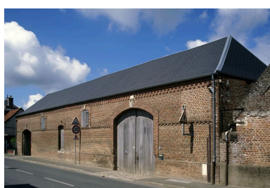
Bettencourt-Saint-Ouen, ferme, 47 rue Principale, portant la date et le nom : 1897 LECAT. Phot. Marie-Laure Monnehay-Vulliet IVR22_20098000191XA
