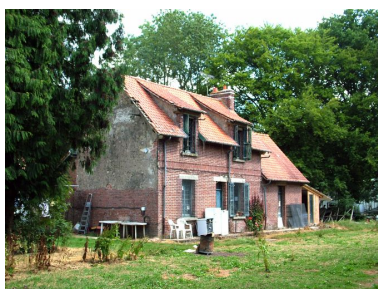
Fransu, maison forestière dite Maison Rouge, en lisière de la forêt de Ribeaucourt, 2e quart du 20e siècle. Phot. Frédéric Fournis IVR22_20108001903NUCA
