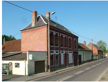
Pernois, ancienne boucherie et ancien café, 469 et 487 rue du Général-Leclerc, 2e moitié du 19e siècle. Phot. Frédéric Fournis IVR22_20108001696NUCA
