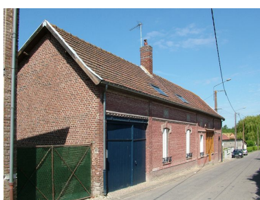
Bettencourt-Saint-Ouen, maison, 7 rue du Marais, présentant la devanture d'un ancien commerce, années 1920-1930. Phot. Frédéric Fournis IVR22_20098005225NUCA
