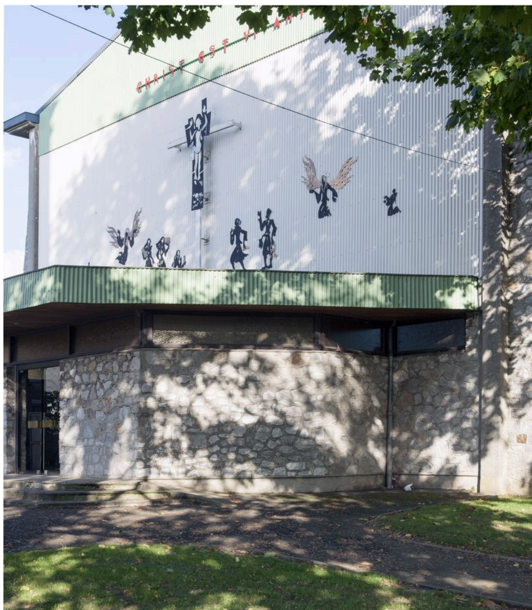
Vue extérieure du flanc droit du narthex.
