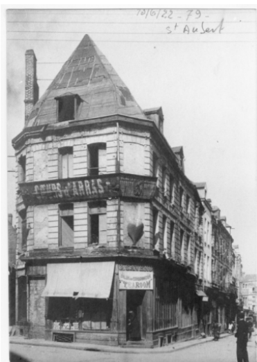
Vue de l'immeuble du 11-13 rue Saint-Aubert, construction avant l'alignement de la rue. Phot. Thibaut Pierre (reproduction) IVR31_20096200304NUCB
