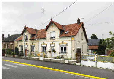
Vue générale de trois-quarts. Phot. Thierry Lefébure IVR32_20160200117NUC2A
