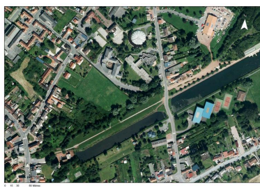
Le site, selon la même emprise, sur une photographie aérienne de 2015 (IGN. Photothèque nationale. 2015). Repro. Jean-Marc Ramette IVR32_20206200046NUCA
