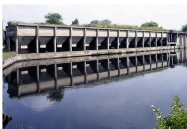
Vue générale vers le nord-ouest en 1996. Phot. Thierry Petitberghien IVR31_19966200940ZA
