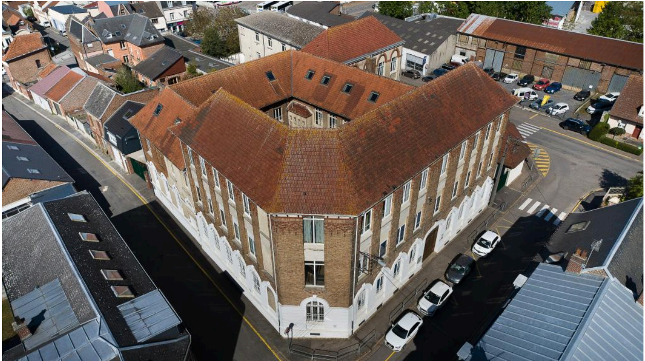
Vue aérienne générale de l'école depuis l'angle des rues Neuve et Lecointe.
