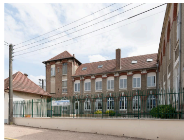
Vue générale depuis la rue du Général-Frère de la façade nord du bâtiment fermant le côté nord de la cour des petits. Phot. Marc Kérignard IVR32_20226200036NUCA
