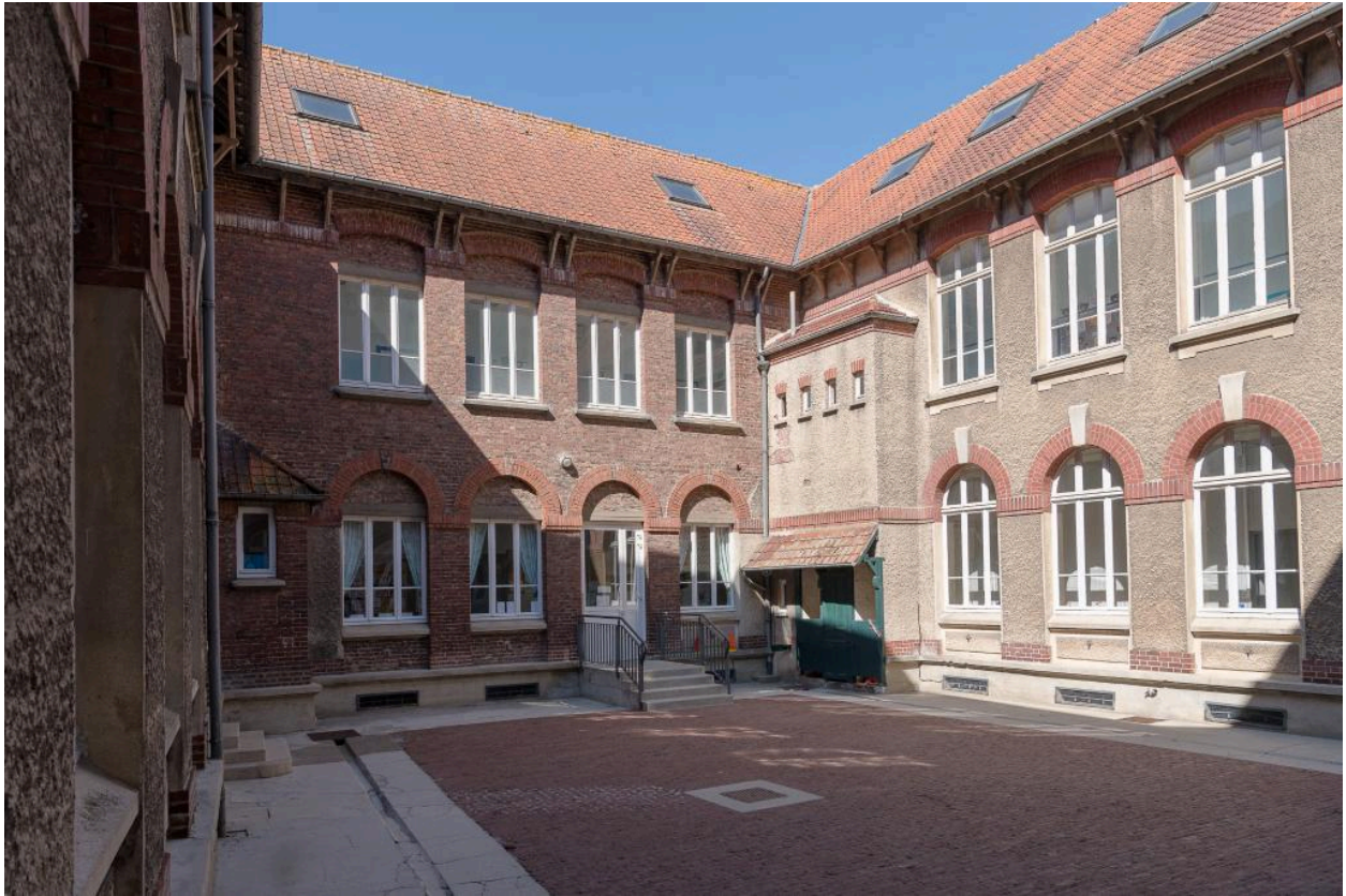
Vue des bâtiments nord et ouest de la cour des petits.
