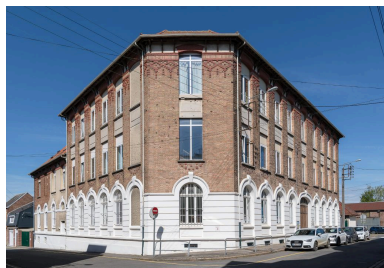
Vue générale de l'école depuis la rue Lecointe. Phot. Marc Kérignard IVR32_20226200029NUCA
