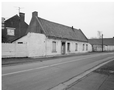
Vue générale. Phot. Philippe Dapvriil IVR31_20055900497X
