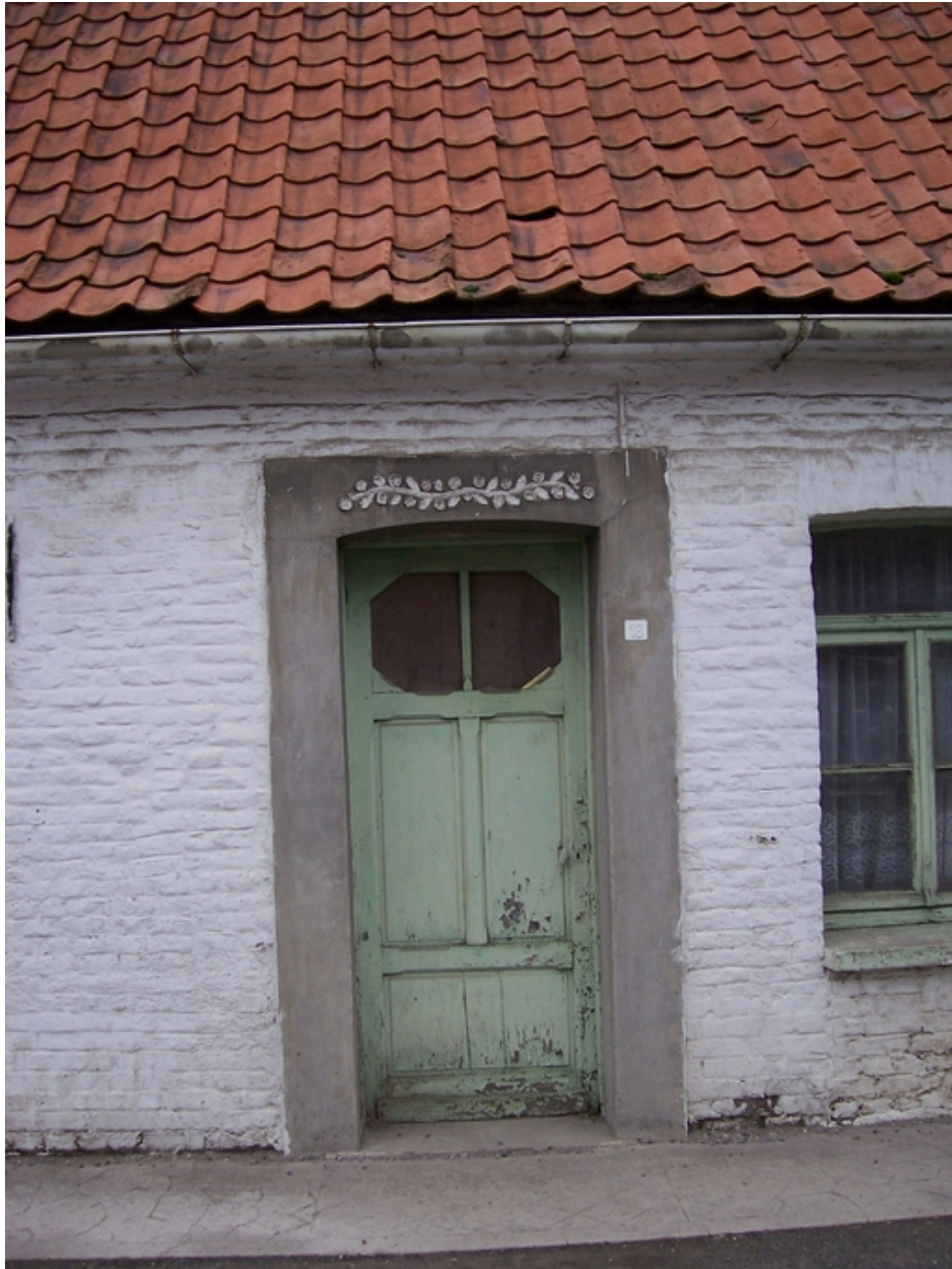
Détail de la porte du logis.
