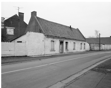
Vue générale. Phot. Philippe Dapvril IVR31_20055900497X
