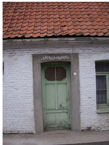
Détail de la porte du logis. Phot. Cyril Cailleau IVR31_20055907391NUCA
