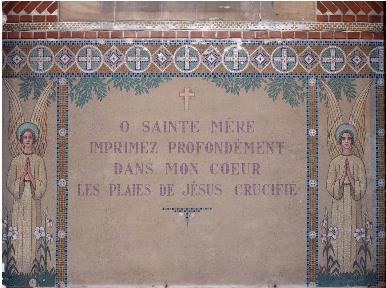
Chapelle Notre-Dame-de-Piété. Panneau de fausse mosaïque : détail du panneau latéral droit.
