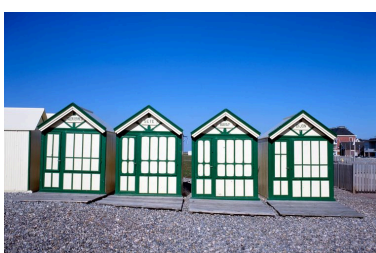
Ensemble de cabines, vue de face. Phot. Marie-Laure Monnehay-Vulliet IVR22_20038001036XA
