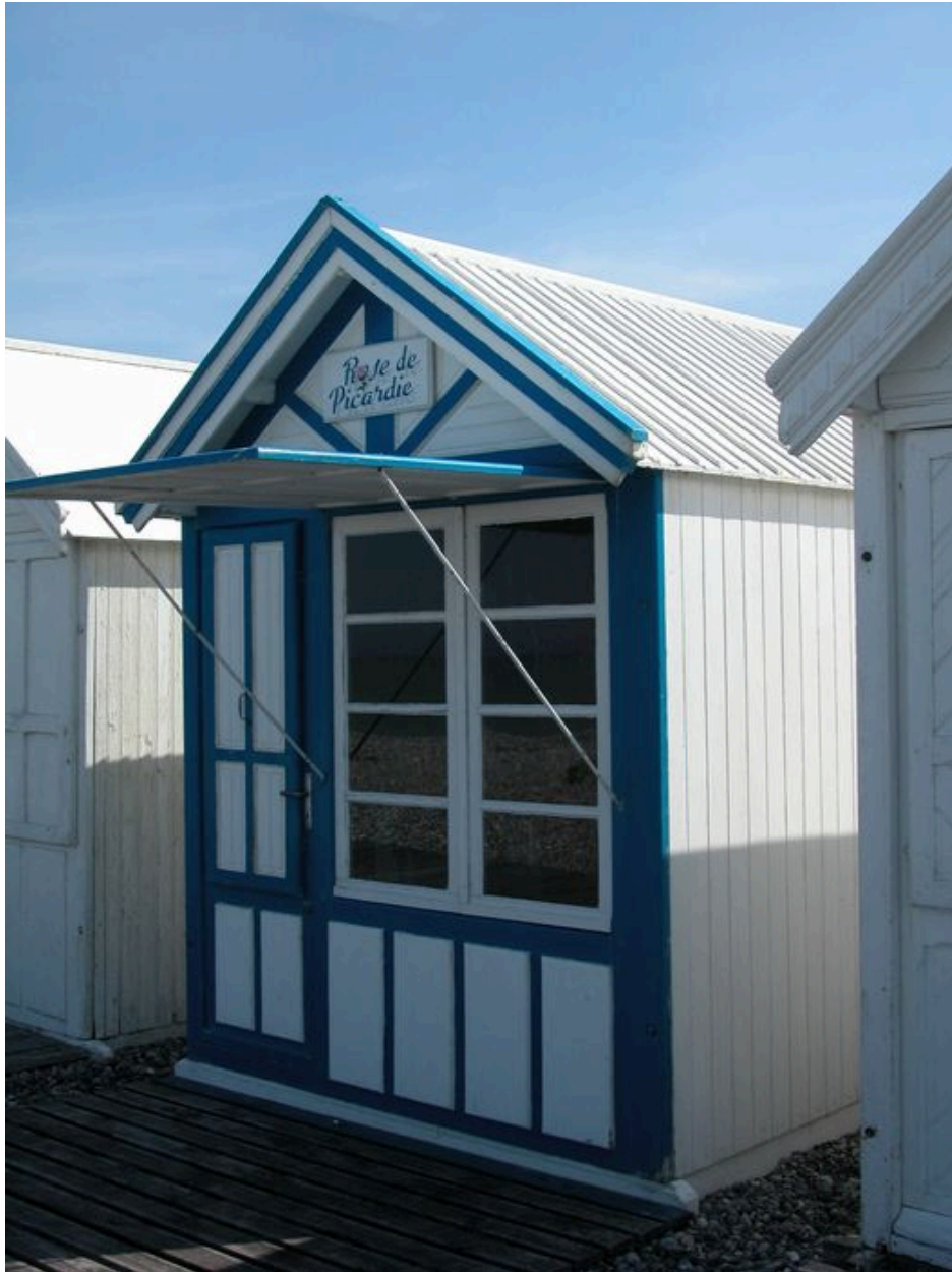
Détail d'une cabine ouverte.
