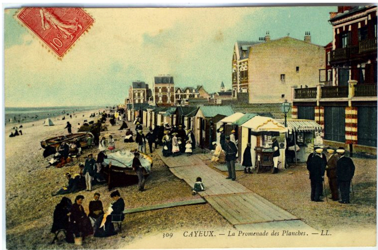
Les cabines de bains et les planches, carte postale, 1er quart 20e siècle (coll. part.).
