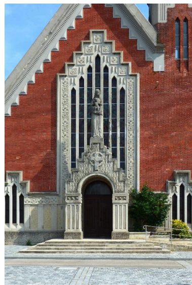
Vue de détail sur le portail principal. Phot. Isabelle Barbedor IVR32_20170205260NUCA
