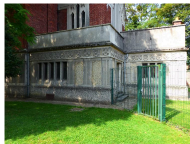
Vue de la sacristie. Phot. Isabelle Barbedor IVR32_20170205267NUCA
