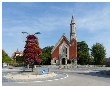
Vue de situation depuis le rond-point. Phot. Isabelle Barbedor IVR32_20170205262NUCA
