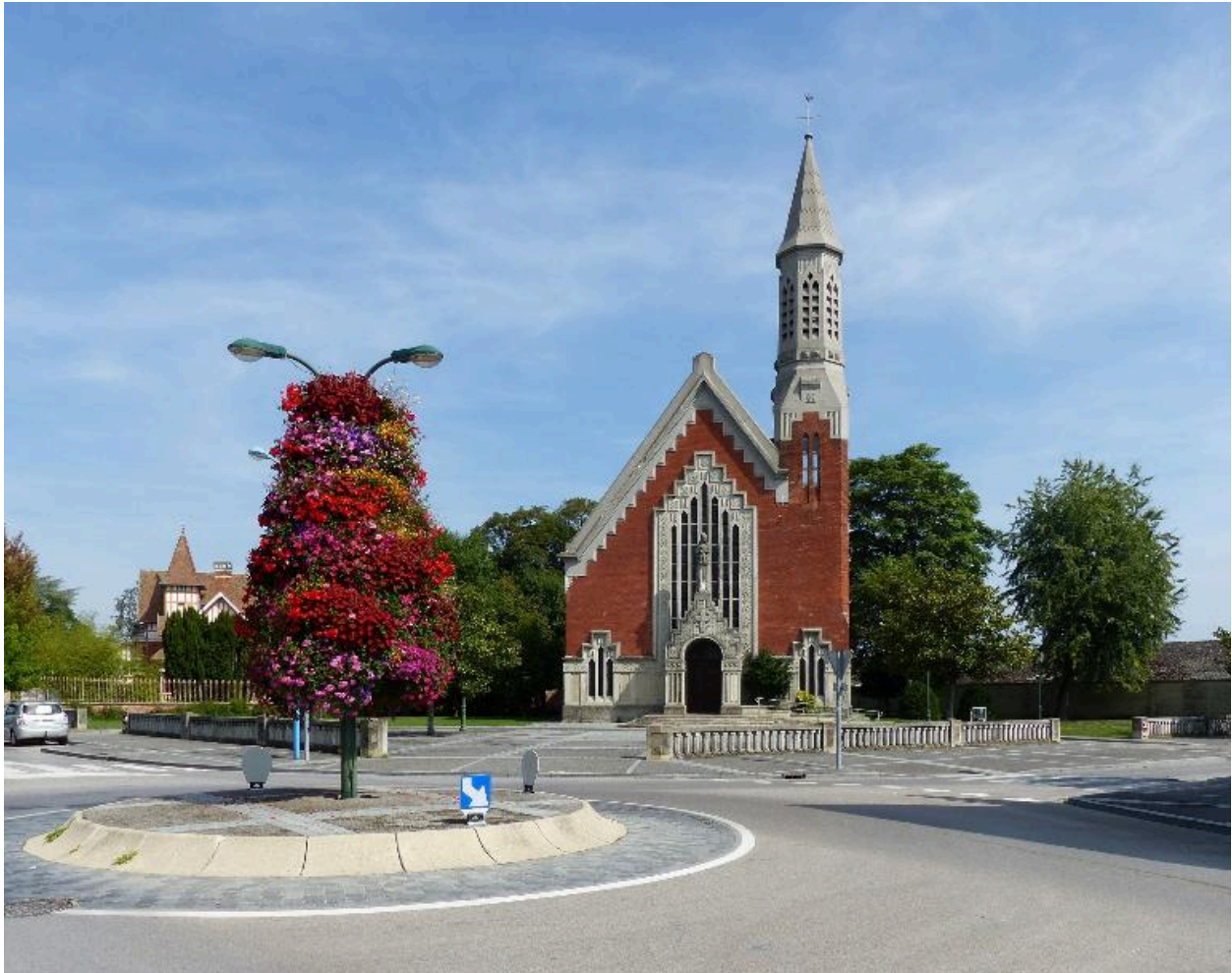
Vue de situation depuis le rond-point.
