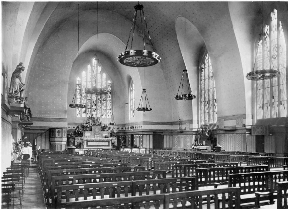
Fargniers. Église paroissiale. Vue intérieure vers le chœur. Photographie, vers 1930 (Archives diocésaines de Soissons).
