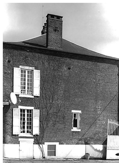
Élévation du mur pignon ouest du logis. Phot. Franck Bürjes IVR22_19990201244X
