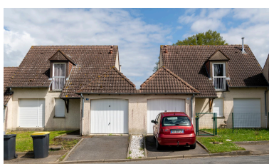
Lotissement HLM des Haies Villet, n°5-3 de la Grande Rue, vue prise depuis l'ouest. Phot. Marc Kérignard IVR32_20236000535NUCA
