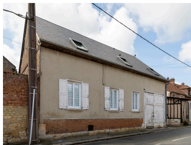
Logis sur rue avec entrée charretière, n°72 de la Grande Rue, vue prise depuis le nord. Phot. Marc Kérignard IVR32_20236000506NUCA
