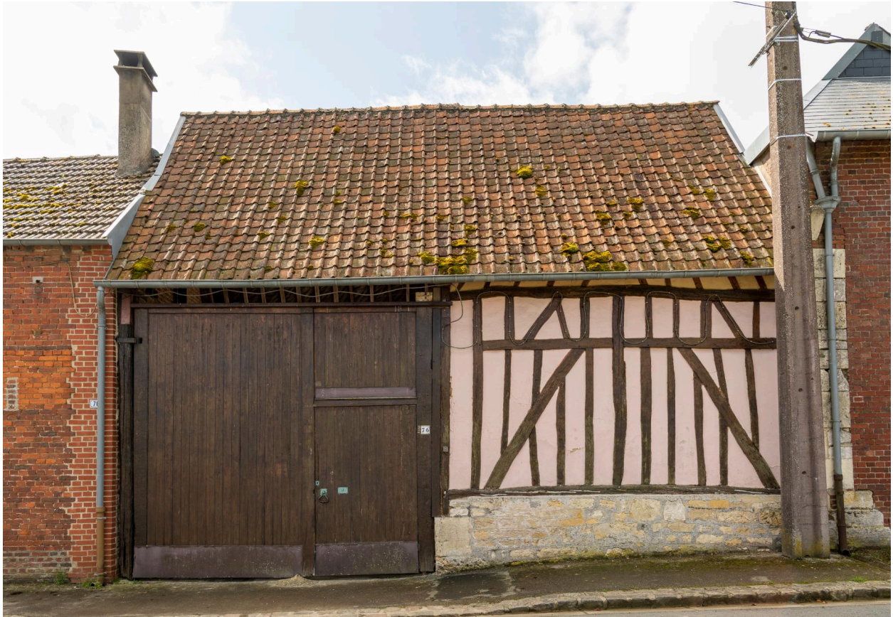
Grange sur rue, n°76 de la Grande Rue, vue prise depuis le nord.
