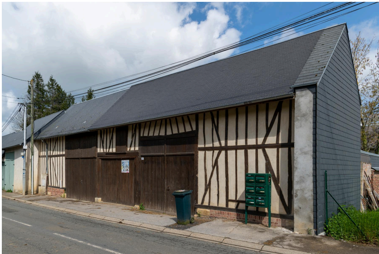
Ancienne grange sur rue avec entrée charretière, n°41 de la Grande Rue, vue prise depuis le sud-est.
