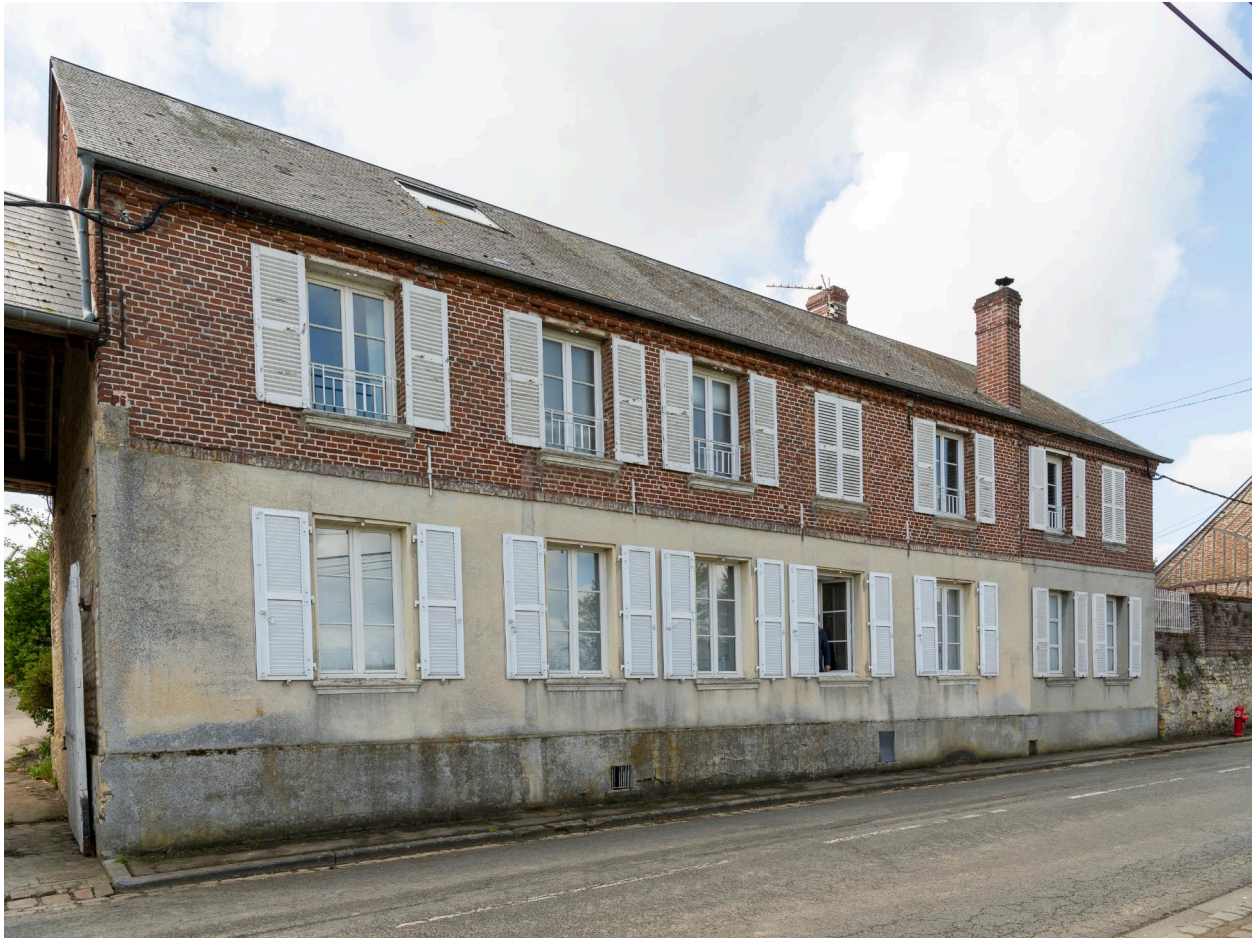
Logis de la ferme au n°74 de la Grande Rue, vue prise depuis le nord.
