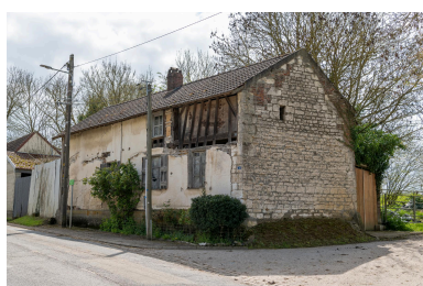
Logis en torchis et pan de bois, n°4 de la Grande Rue, vue prise depuis le nord. Phot. Marc Kérignard IVR32_20236000536NUCA
