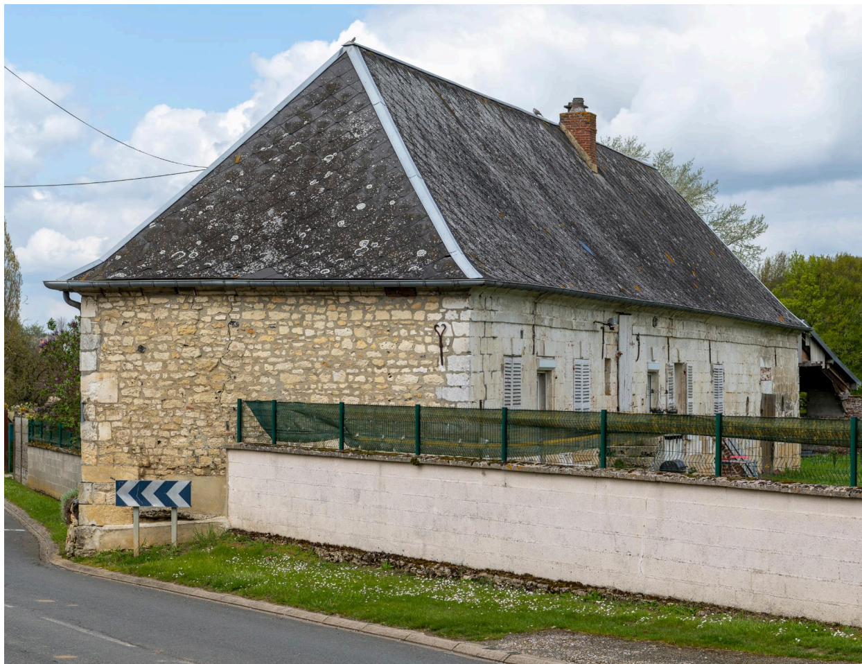
Logis avec date portée "1791", n°9 de la Grande Rue, vue prise depuis le sud.
