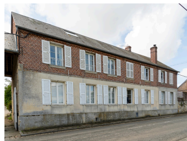
Logis de la ferme au n°74 de la Grande Rue, vue prise depuis le nord. Phot. Marc Kérignard IVR32_20236000505NUCA
