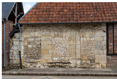
Ancienne école (?), n°87 de la Grande Rue, vue prise depuis le sud. Phot. Marc Kérignard IVR32_20236000515NUCA
