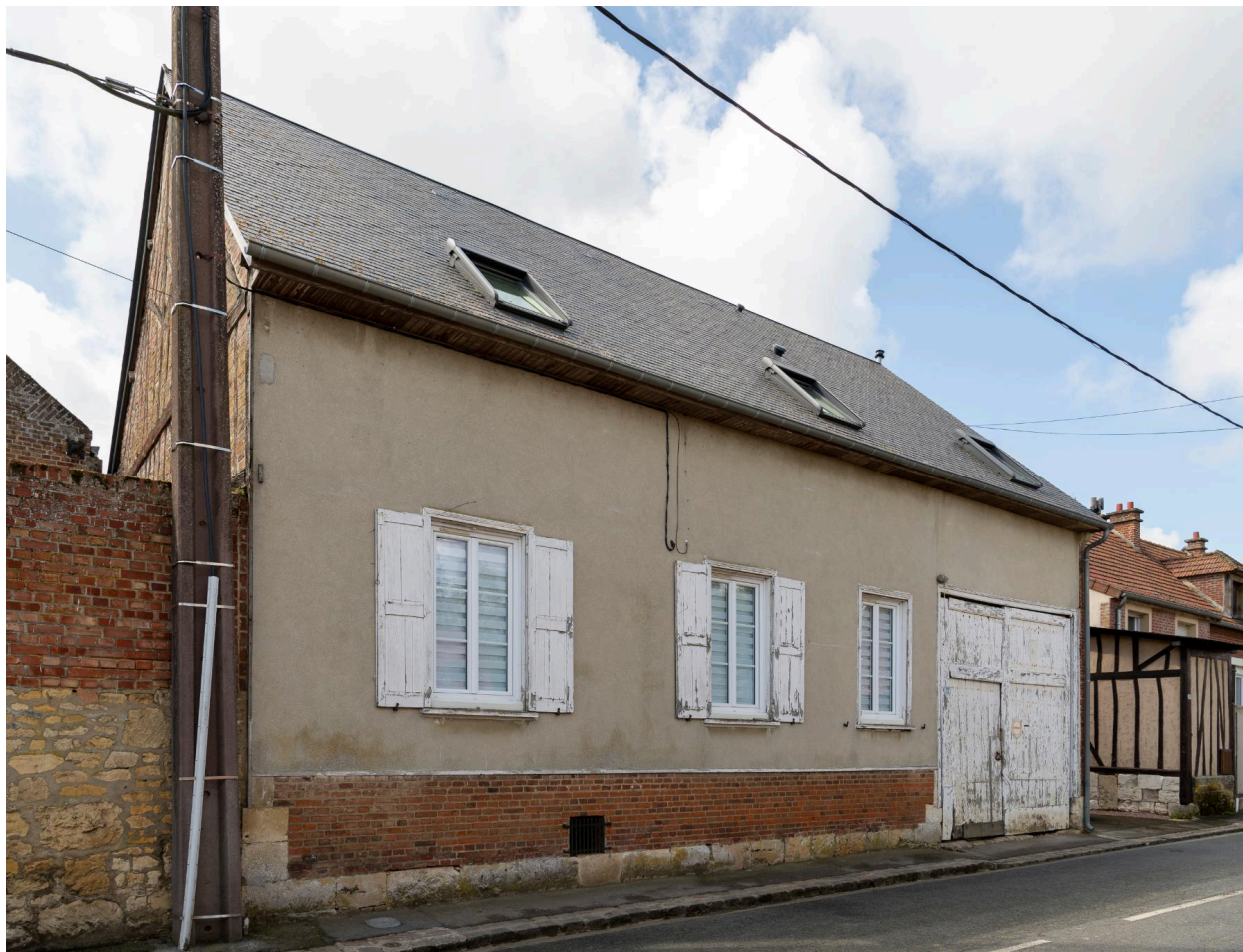
Logis sur rue avec entrée charretière, n°72 de la Grande Rue, vue prise depuis le nord.
