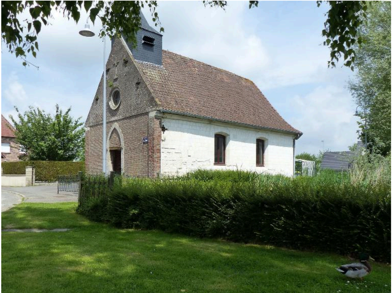
Vue de situation, depuis la place.
