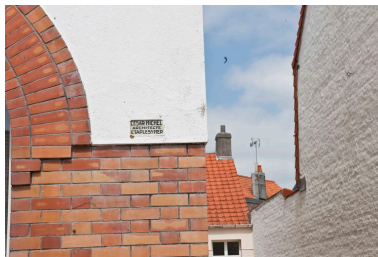
Plaque avec signature de l'architecte. Phot. Hubert Bouvet IVR31_20136200253NUCA
