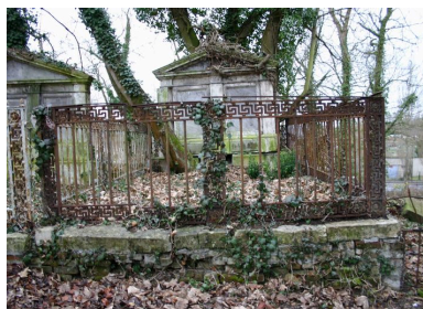
Vue générale. Phot. Caroline Vincent
