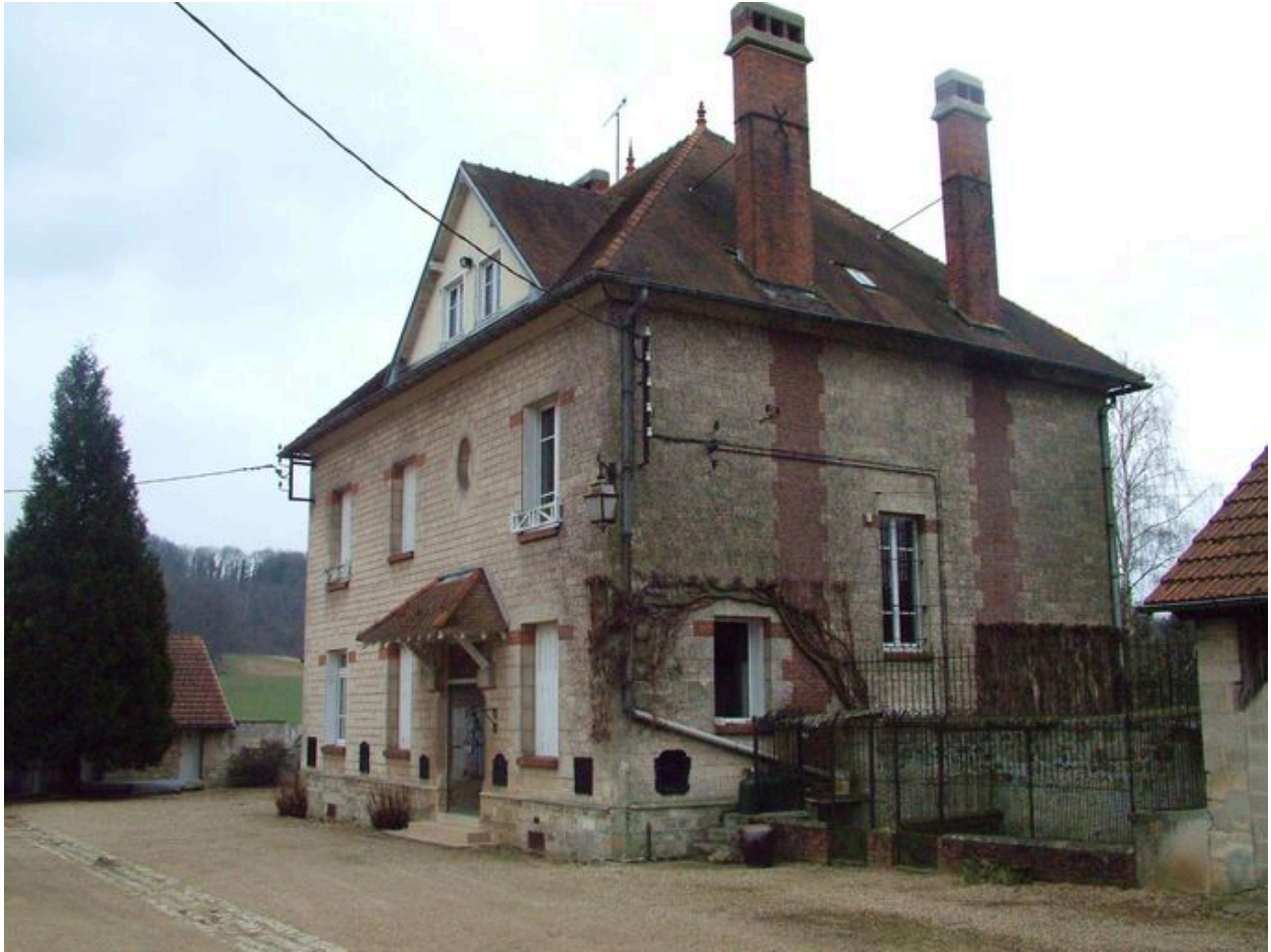
Vue générale du logis de la ferme.
