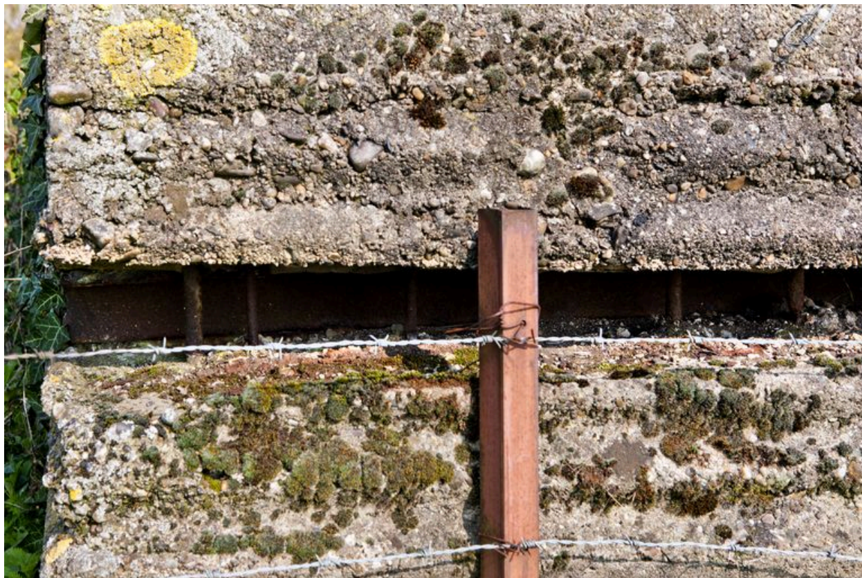
Elévation ouest, détail d'une cellule d'éclatement
