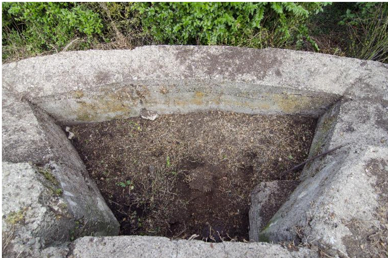
Elévation nord, la cuve à canon, vue verticale (au grand angle)
