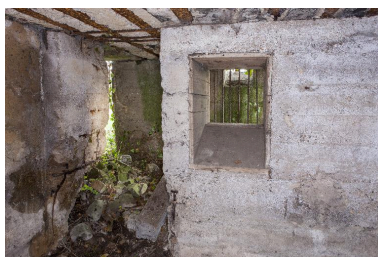
Depuis la salle ouest, vers le couloir de distribution. Phot. Pierre Thibaut IVR31_20155902002NUCA
