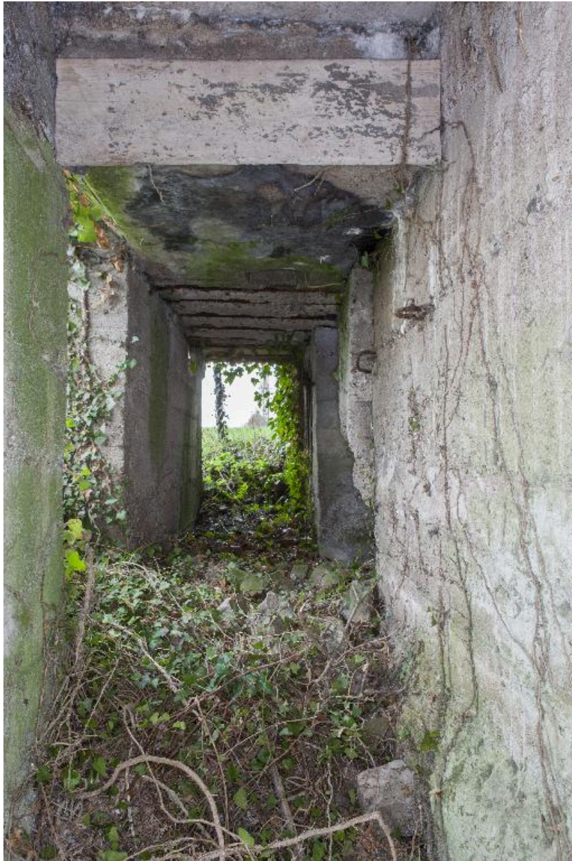
Couloir de distribution, vers l'ouest
