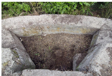
Elévation nord, la cuve à canon, vue verticale (au grand angle) Phot. Jean-Marc Ramette IVR32_20165901524NUCA
