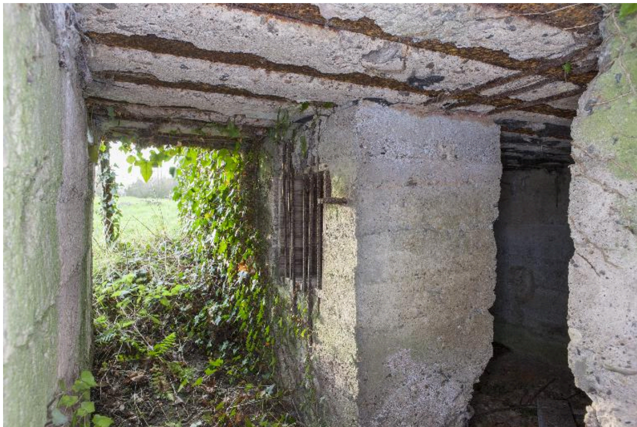
Depuis le couloir, l'entrée de la salle ouest
