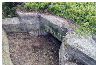
Elévation nord, la cuve à canon (au grand angle) Phot. Jean-Marc Ramette IVR32_20165901526NUCA
