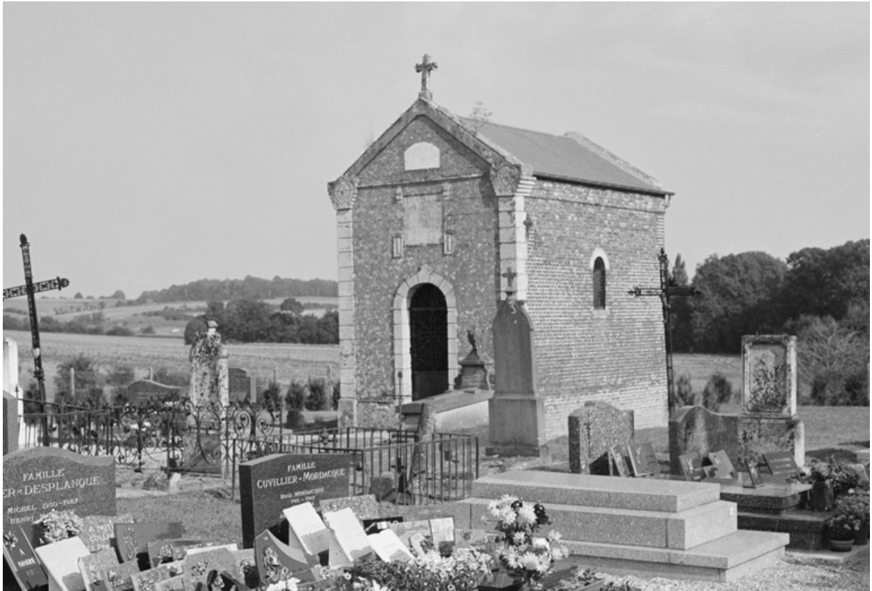
Vue générale, depuis le sud-ouest avec la chapelle construite en 1888.
