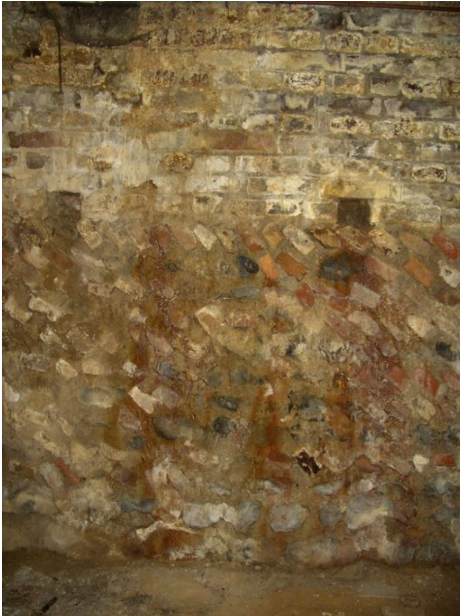
Vue des fondations visibles depuis l'intérieur de la cave.
