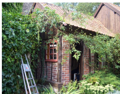
Vue d'une ancienne dépendance agricole. Phot. Inès Guérin IVR22_20068005173NUCA
