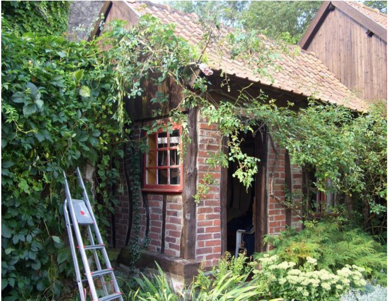
Vue d'une ancienne dépendance agricole.
