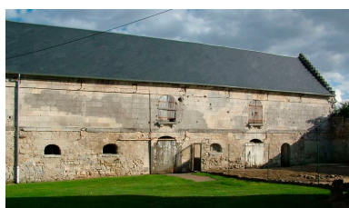
Vue de l'étable Phot. Frédéric Fournis IVR22_20040202815NUCA
