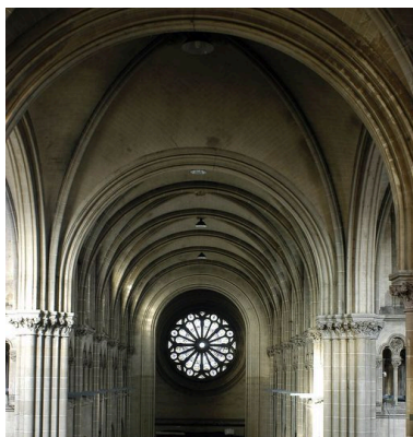
Voûtes de la nef. Phot. Thierry Lefébure IVR22_20058001963NUCA
