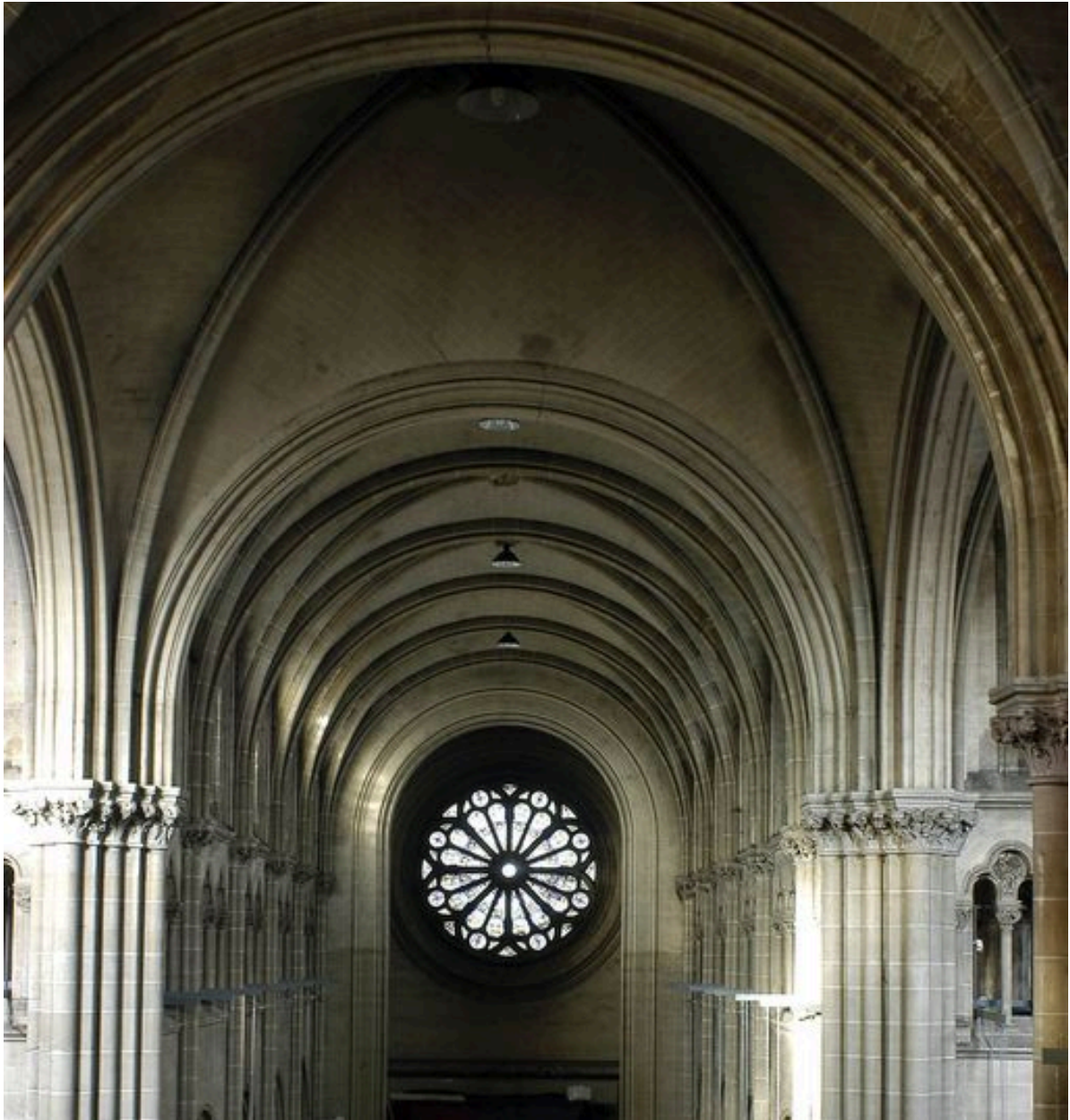
Voûtes de la nef.
