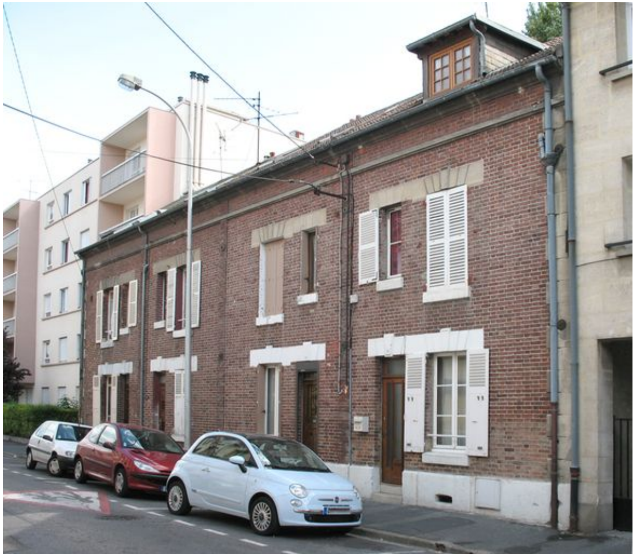
Logement d'ingénieur situé dans cet ensemble de 4 maisons accolées et acheté par la Vieille-Montagne en 1952.
