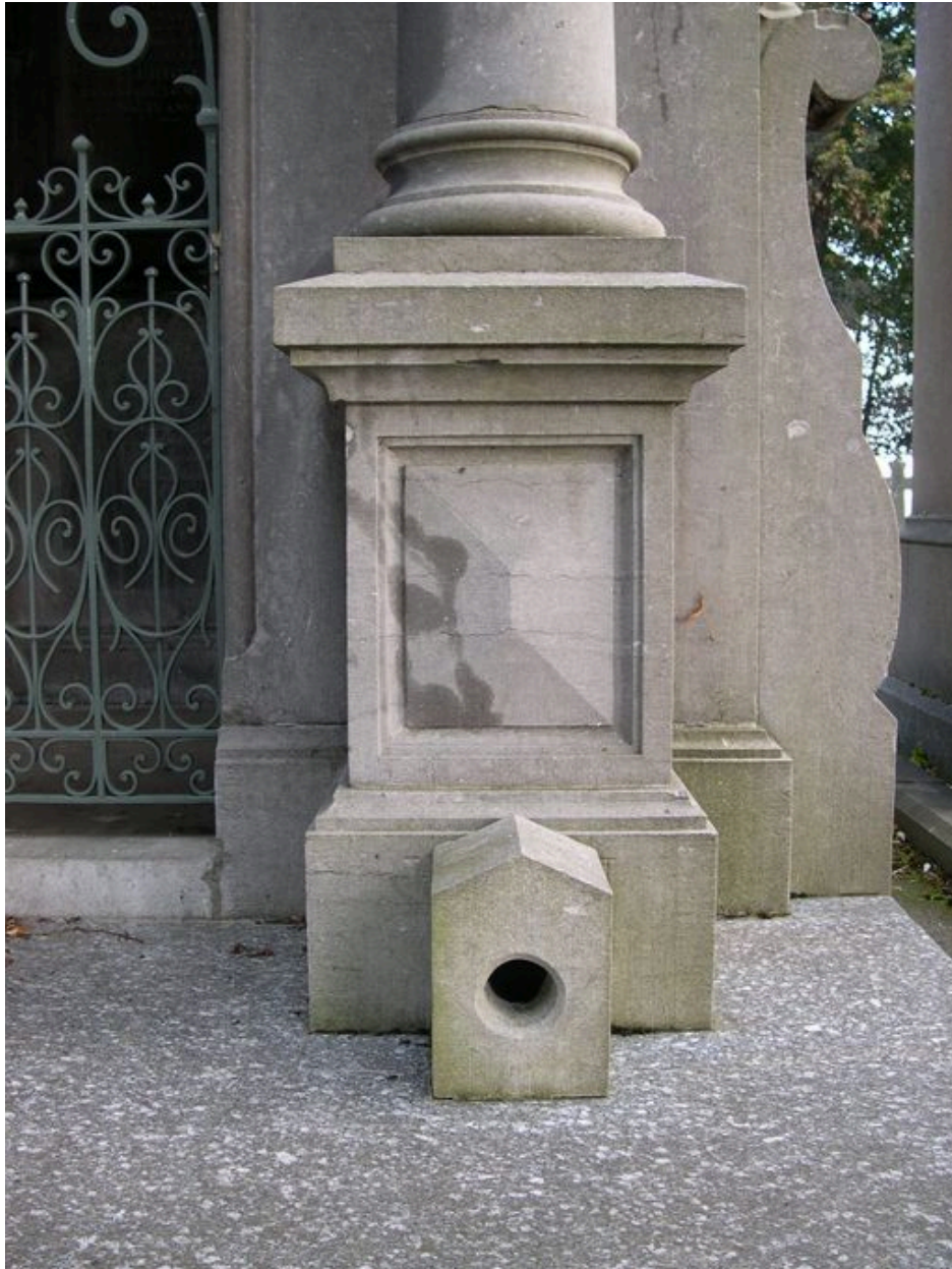
Vue de l'aération du caveau.
