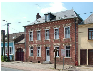
Vue générale. Phot. Frédéric Fournis IVR22_20108001265NUCA
